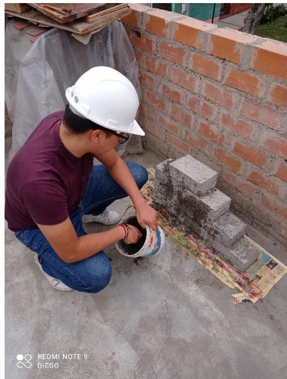
Armado de murete
