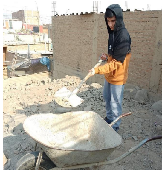
Figura 08: Obtención del agregado fino
