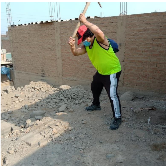
Figura 07: Obtención del agregado fino
