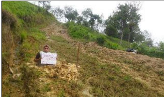
**Fotografía 05.** Se observa la excavación de la calicata 05 en la progresiva 4+000.00
