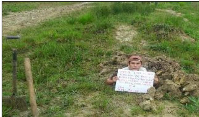
**Fotografía 02.-** Se observa la excavación de la calicata 02 en la progresiva 1+000.00
