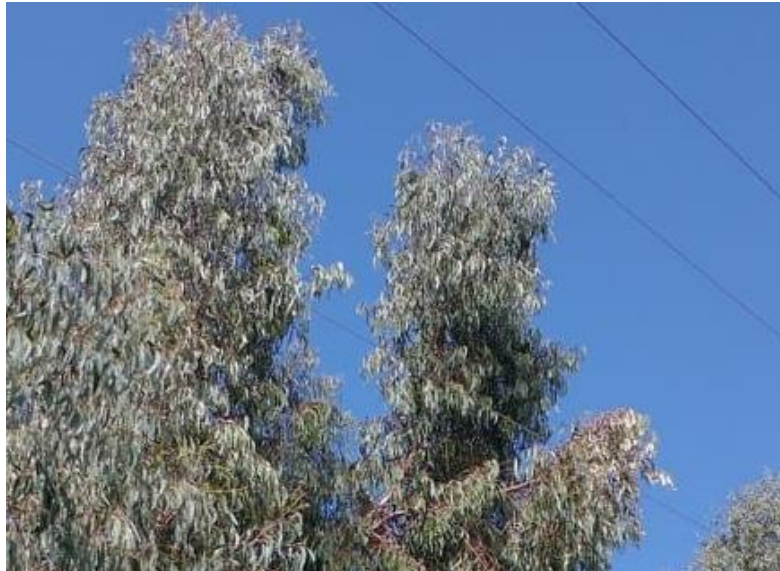
Figura 10: Árboles cerca de la línea de media tensión.
