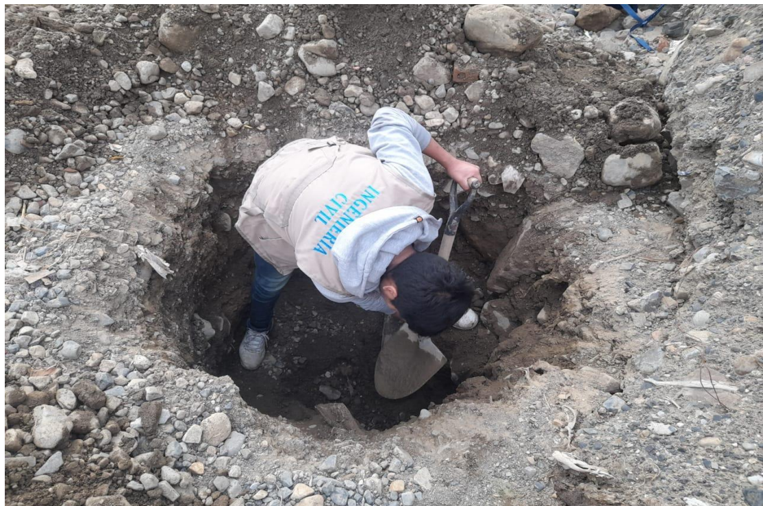
Fig. 8: Excavación del terreno para el estudio de suelo
