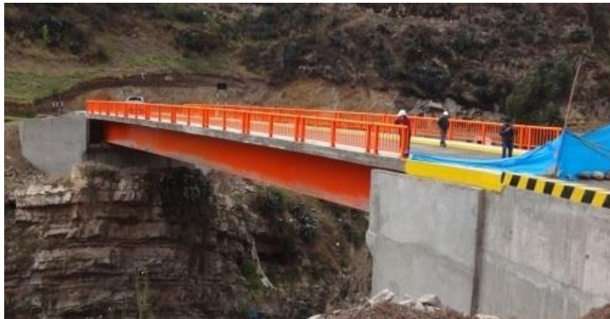
Figura 3. Puente de sección compuesta en Lircay-Huancavelica.
