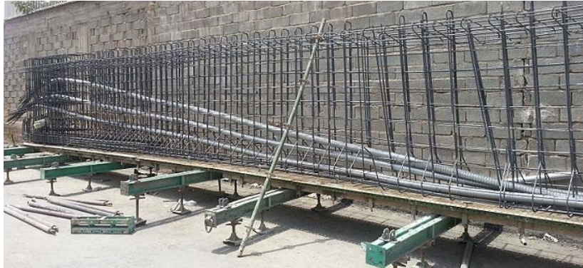
Figura 8. Distribución de torones en la viga.
