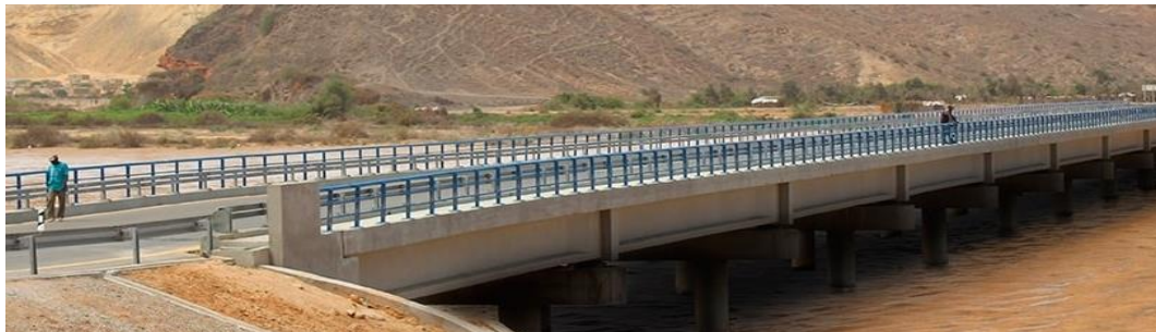
Figura 5. Puente de concreto armado postensado en Namibe-Angola.
