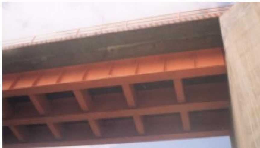
Figura 4. Vista inferior del puente de sección compuesta Lircay.
