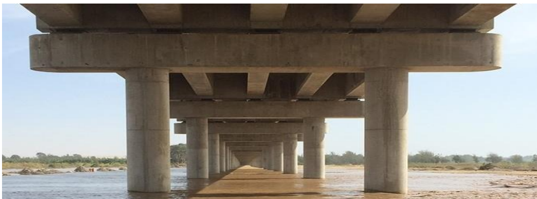
Figura 6. Vista inferior del puente de concreto armado postensado en Namibe.
