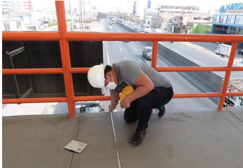
Figura 19. Medición del ancho de tablero del puente San Martín.
