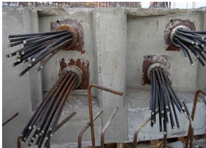
Figura 9. Torones anclados en la viga.
