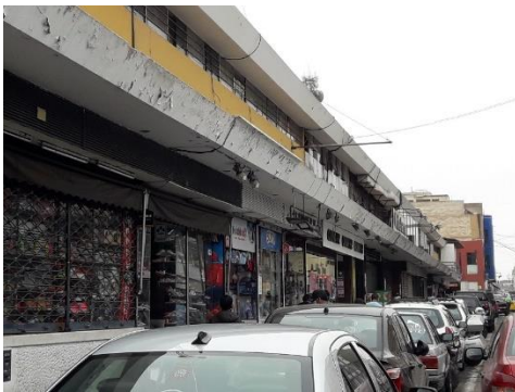
Figura 1: Fachada del Mercado Central de la calle Avacucho.
