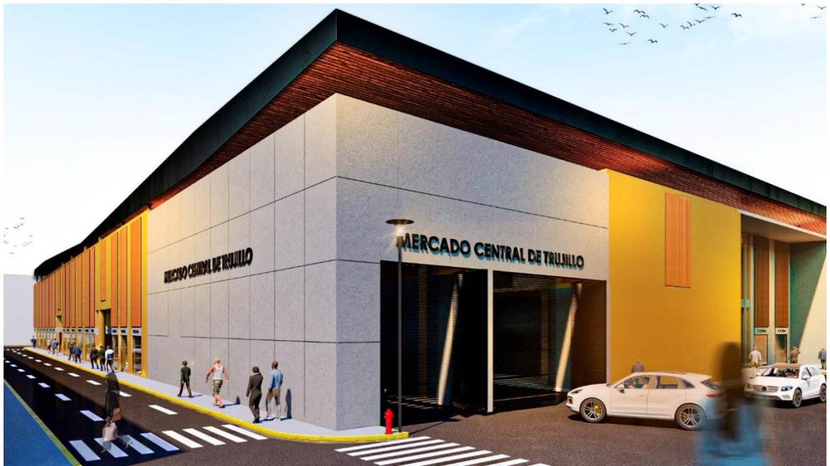
Vista de fachada en perspectiva – Entrada a sótano de estacionamientos por pasaje San Agustín.
