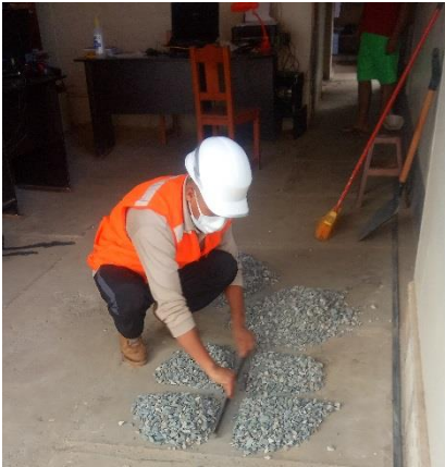
Foto 01.- Cuarteo de los material agregado
