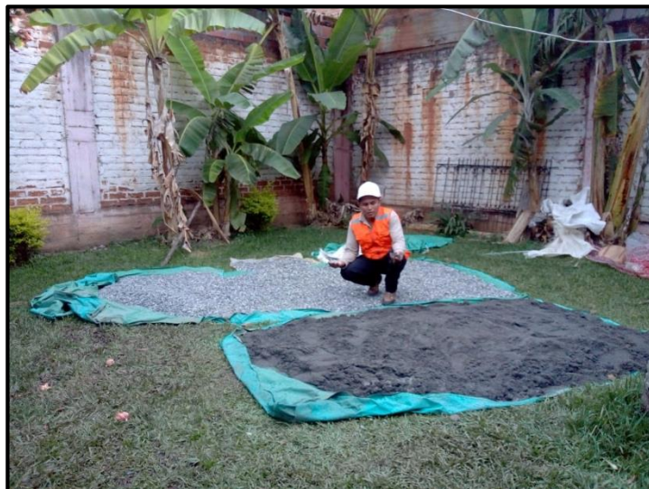
Figura 14: Obtención de los agregados limpio de impurezas
