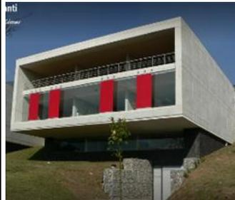
La materialidad es de concreto reforzado, en pórticos y pantallas, Cada módulo es independiente estructuralmente. El material nos muestra una estructura natural, revela su textura en el contacto humano y divide el espacio.
