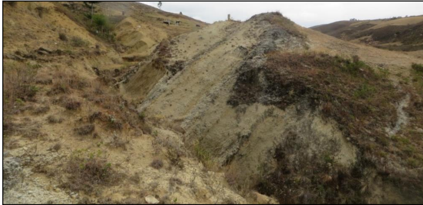
Figura 6. Esta geoforma se origina por la disolución de las calizas por acción de las aguas superficiales producto de las lluvias constantes.
