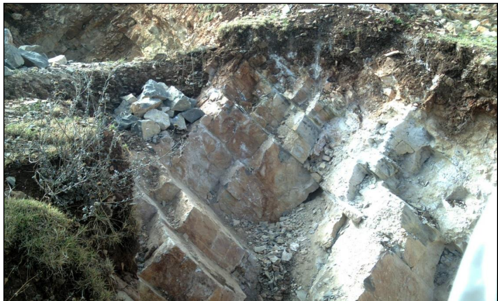
Figura 35. Meteorización de la roca en estación 1.
