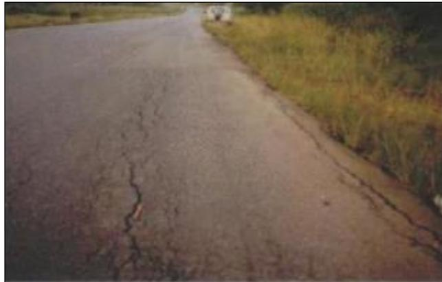
**Figura N° 12:** Falla por grieta longitudinal.
