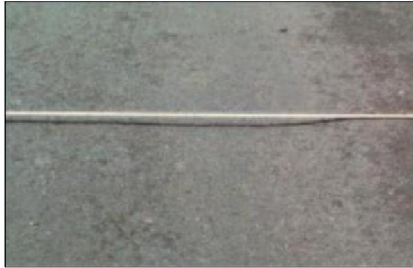
**Figura N° 09:** Falla por hundimiento.
