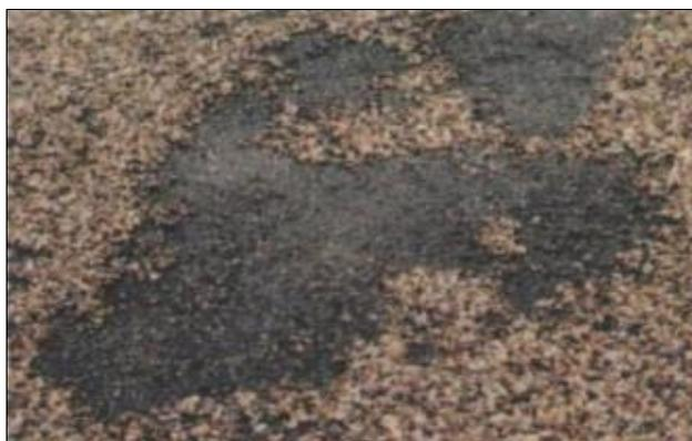
**Figura N° 16:** Falla por desprendimiento de agregados.
