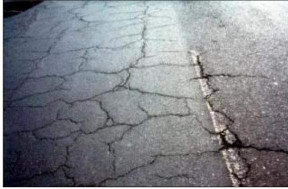
**Figura N° 07:** Falla por agrietamiento en bloque.
