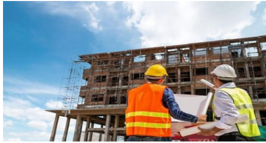
Figura 10. Construcción de obras civiles
