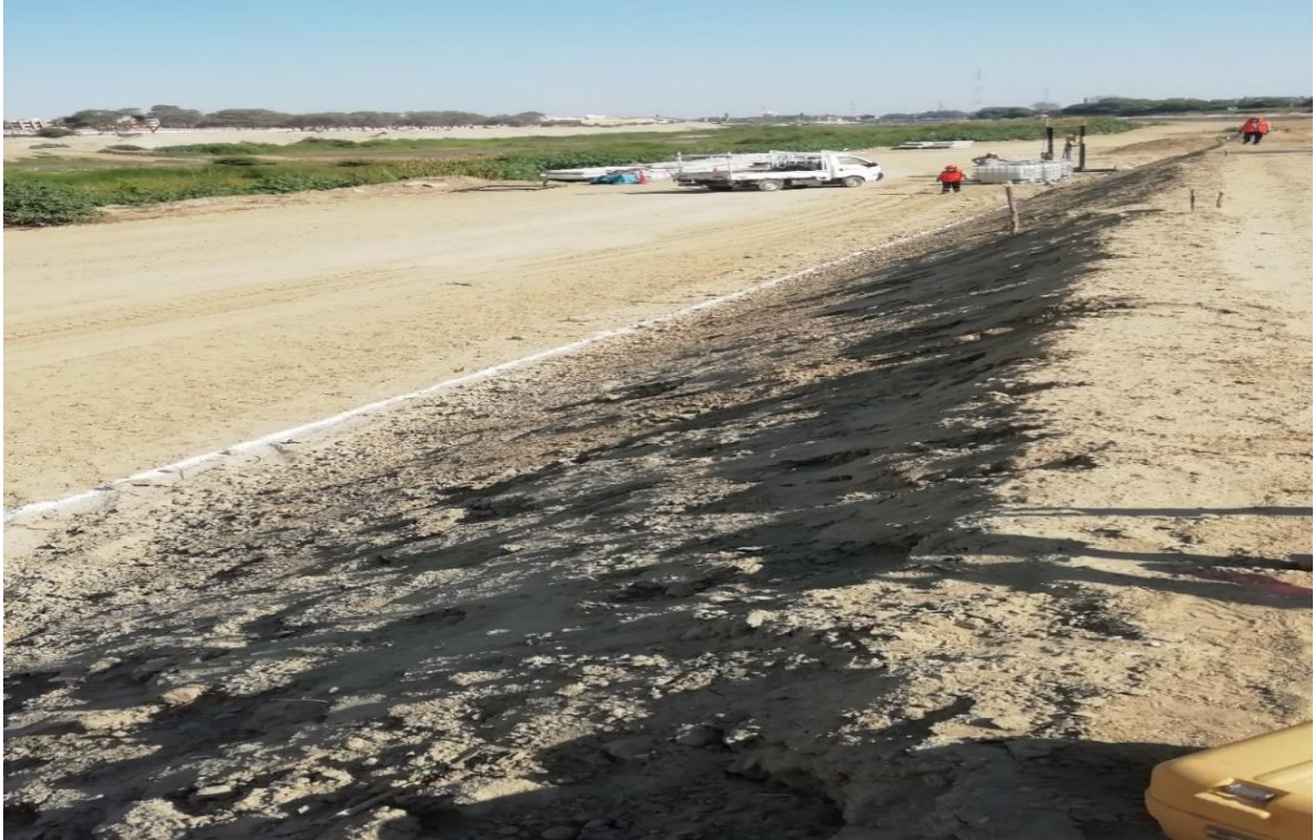
Fig.32 Trazo del eje de tablestacas en campo
