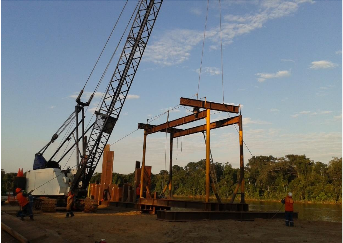
Fig.44, Montaje de plantilla metálica en forma de castillo.
