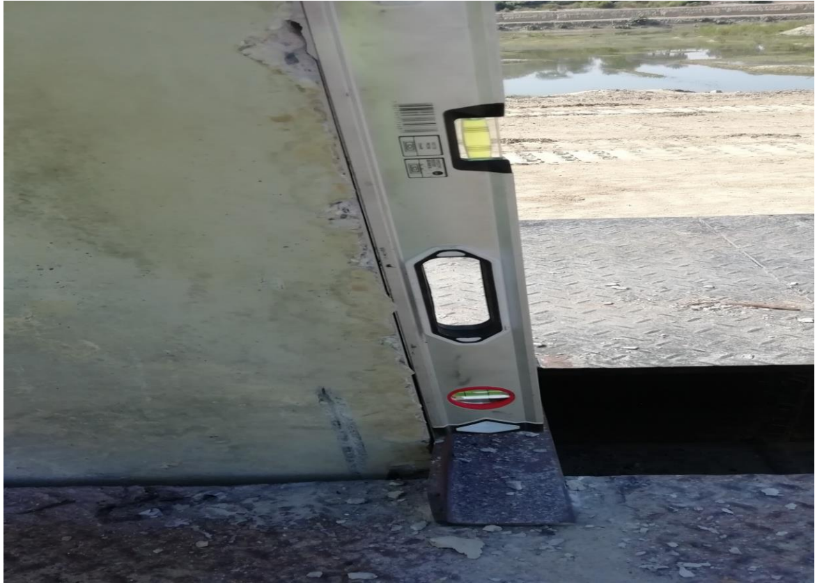
Fig.38 Aplomada de tablestaca.
