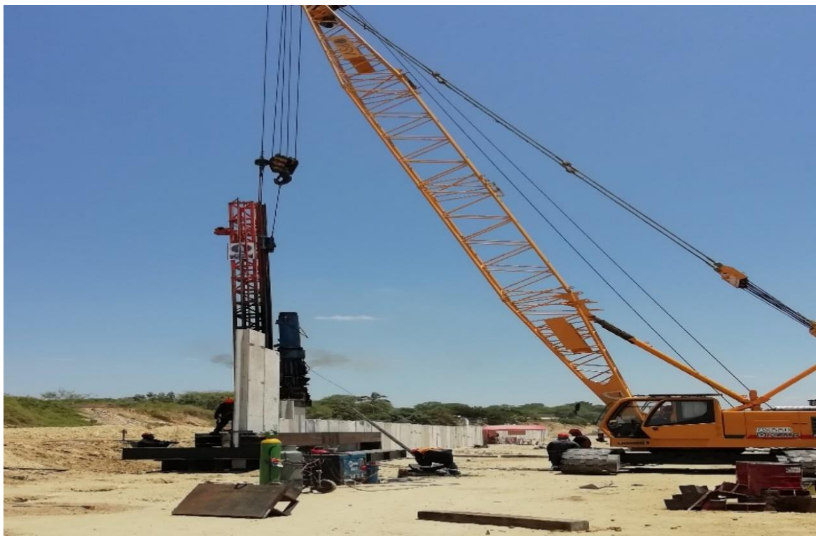
Fig.41 Hincado a una profundidad de 1/3 de la altura de la tablestaca
