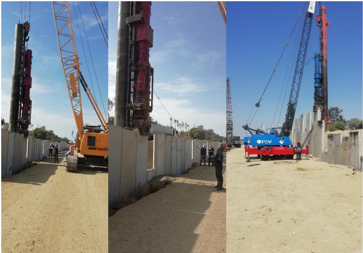
Fig.42 Rehincado de tablestacas.
