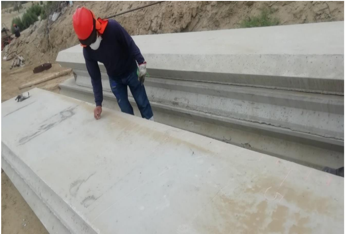
Fig.29 Revisión de la estructura a hincar.
