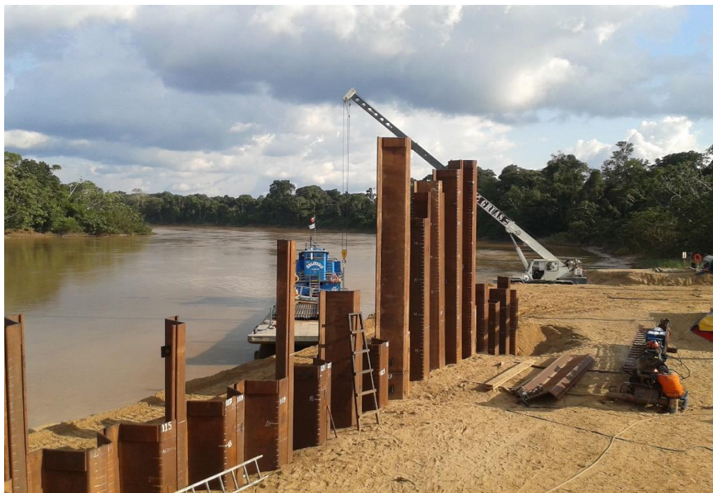
Fig.49, Tablestacas de acero, hincadas en su totalidad.
