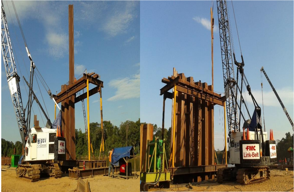
Fig.46, Colocación de tablestaca de acero.
