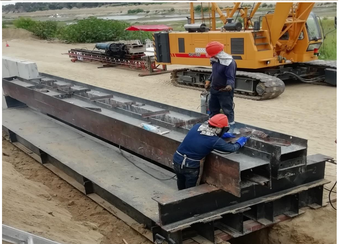
Fig.37 Plantilla metálica de dos niveles, fijados con punto de soldadura.
