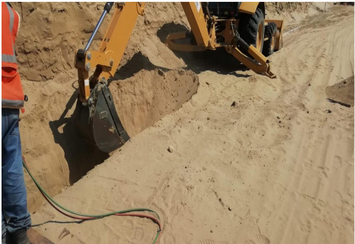
Fig.34 Excavación de zanja, con ayuda de una retroexcavadora.
