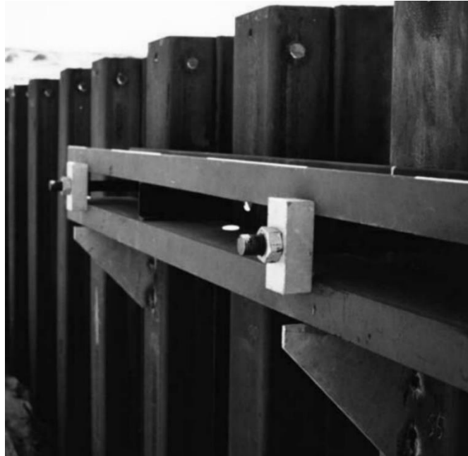
Fig. 16 Carteles de soporte de vigas de reparto
