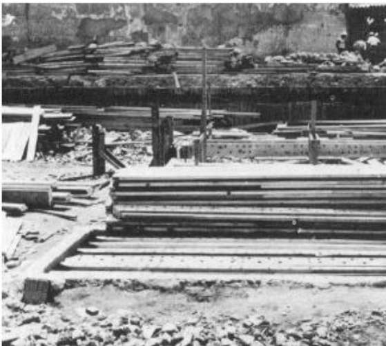
Fig1. Construcción de tablestacas
