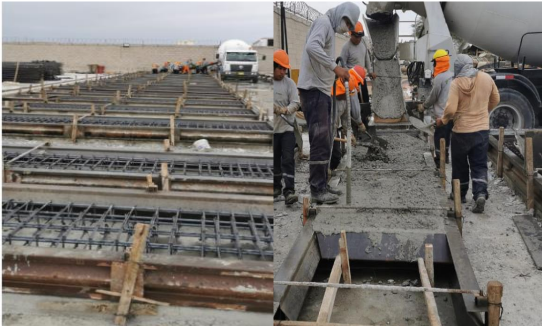
Fig 5, Fabricacion de Tablestacas de concreto(Pronte SAC)
