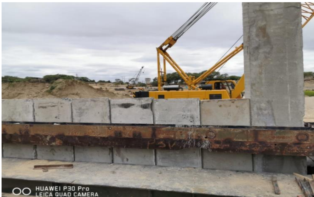
Fig. 6, Vigas metálicas (Rio Piura)
