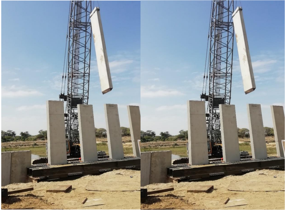
Fig.40 hincado de tablestaca entre 1-2m de profundidad.
