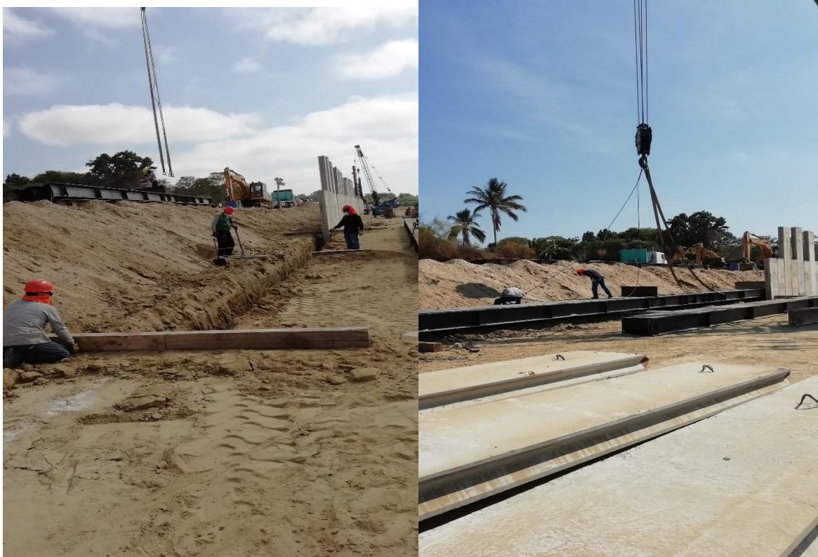
Fig.36 Colocación tacos de madera y perfiles metálicos (plantilla metálica)
