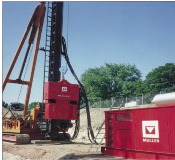
Fig. 20 Martillo vibratorio colgado de una grúa oruga, junto al generador
