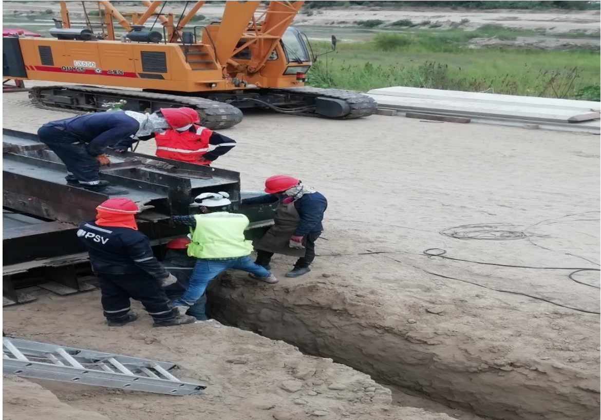
Fig.33 Verificación del alineamiento del eje.
