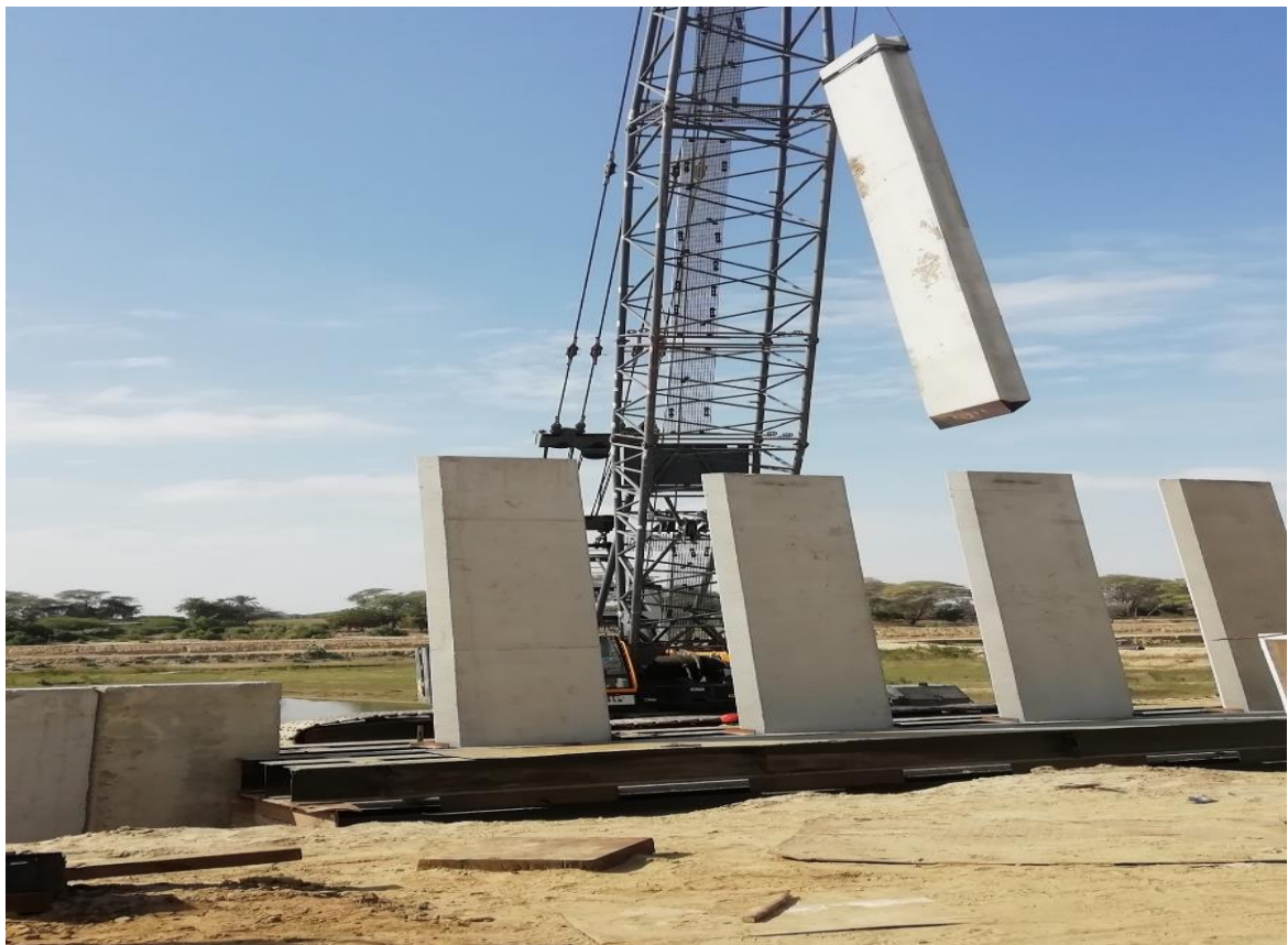
Fig.39 Colocación de tablestacas intercaladamente.
