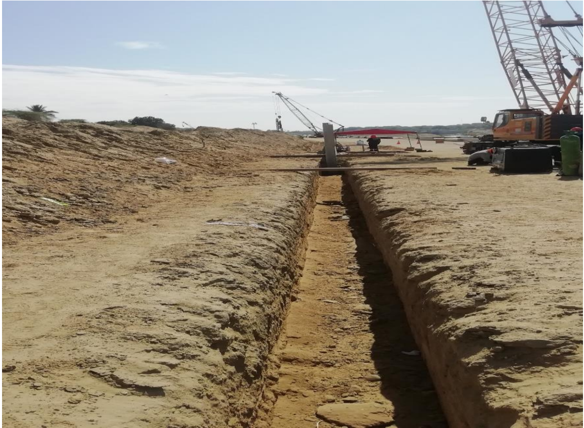
Fig35. zanja de profundidad promedio entre 0.50-1.00m
