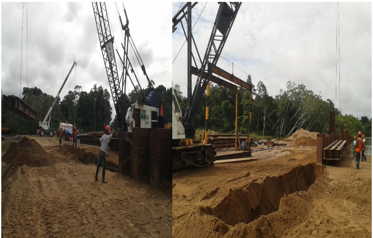
Fig.43, Excavación zanja 1m, para la instalación de la plantilla castillo
