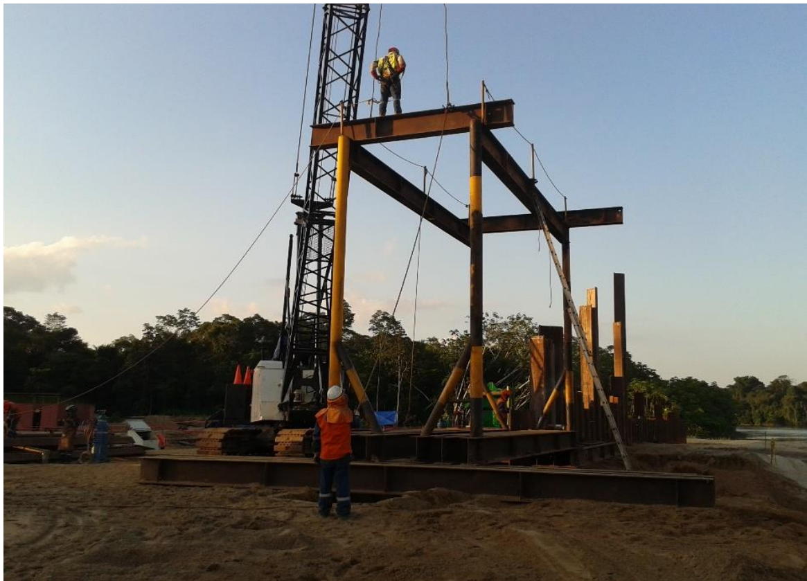
Fig.45, Fijación con soldadura en los puntos o vértices de unión.
