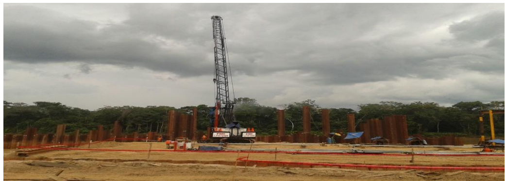
Fig.48, Rehincado tablestacas de acero con martillo de mayor tonelaje.
