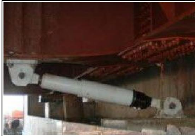
Figura 4: Puente Neimeng Wuxi - China
