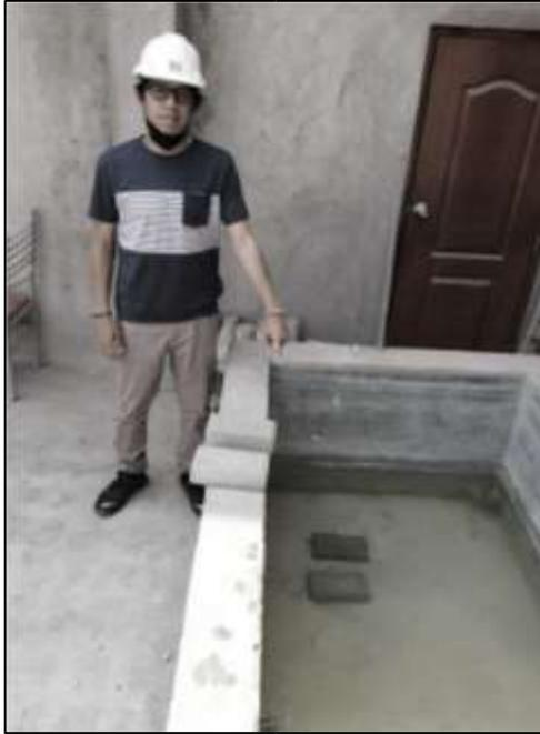
Figura 14: Curado de adoquines de concreto.
