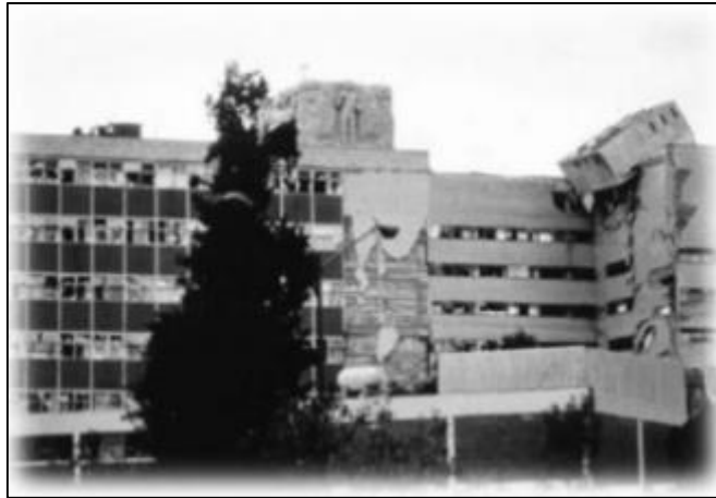
Figura 6. Concentración de masa debido a tanque de agua. Blanco (2012)
