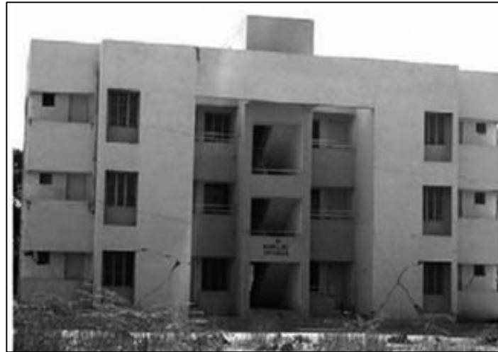
Figura 4. Piso Blando debido a la debilidad de la mampostería. González (2017)
