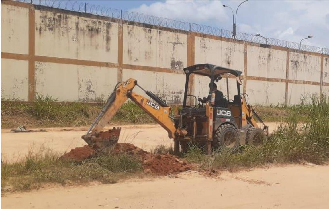
*Figura 79. Ubicación y excavado de la Calicata C-02.*
