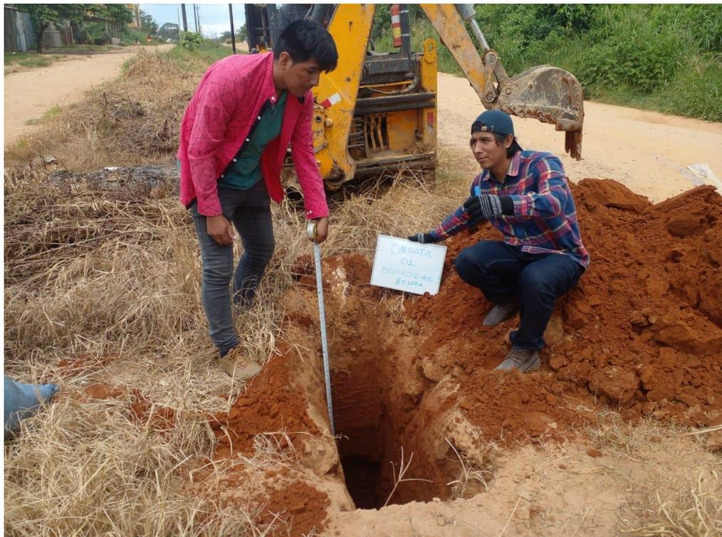
*Figura 78.* Extracción de muestra, profundidad de 1.50 m. (Calicata – 01).
