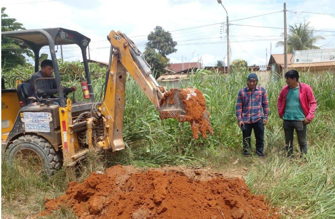
*Figura 81.* Ubicación y excavado de la Calicata C-03.
