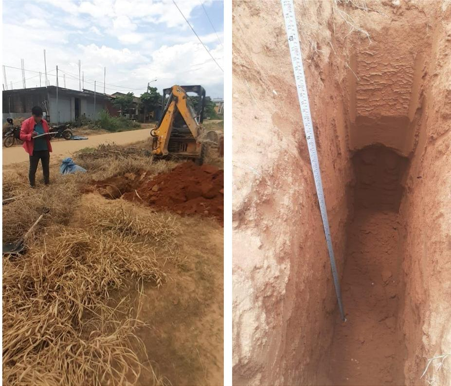
*Figura 77.* Ubicación y excavado de la Calicata C-01.
