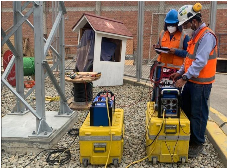
Foto 07. Medición de resistencia por método convencional utilizando equipos con fuente de corriente en SPAT2.
