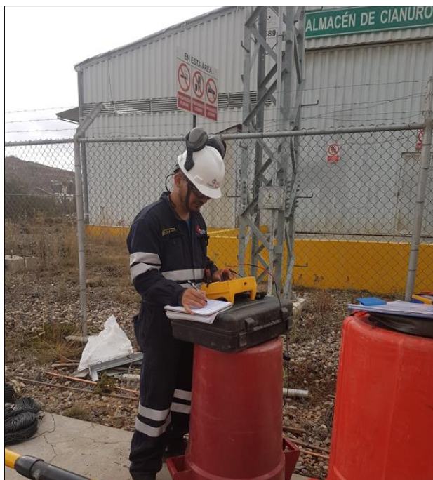
Foto 01. Medición de resistencia en SPAT1 utilizando telurómetro.
