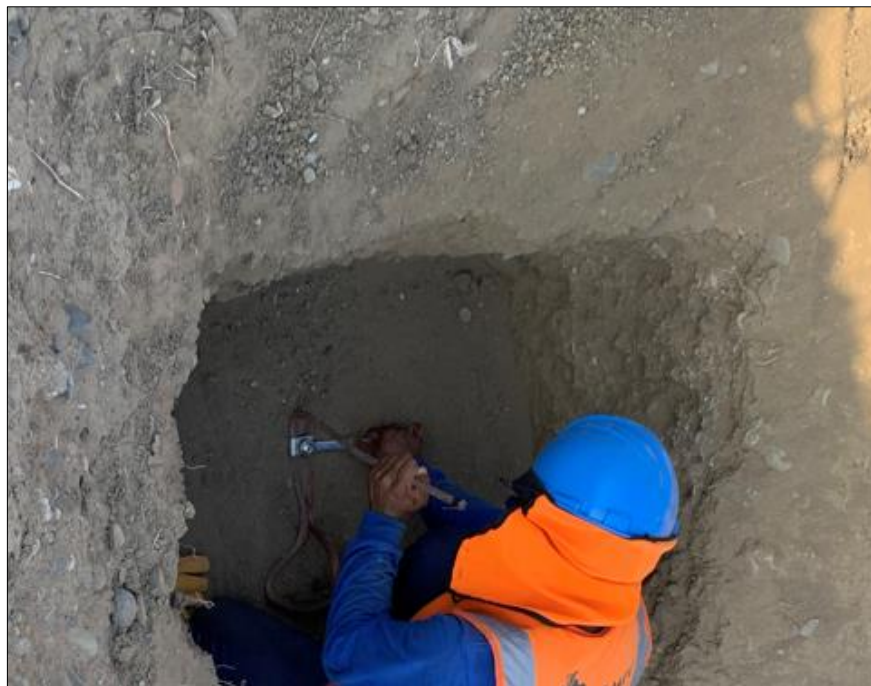
Foto 04. Elaboración de pozos auxiliares para medición en SPAT2.
