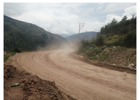
Figura 43. Evidencia del estado actual de la vía de evitamiento con el exceso de polvo
