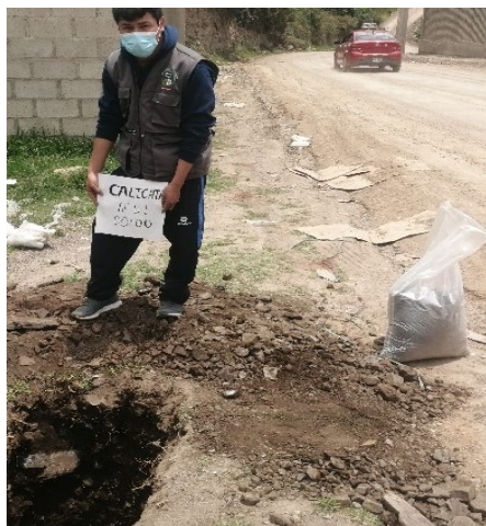
Figura 48. Zona de extracción de muestra C-1 00+00 KM
