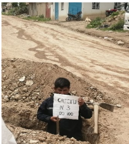
Figura 50. Zona de extracción de muestra C-3 00+700
