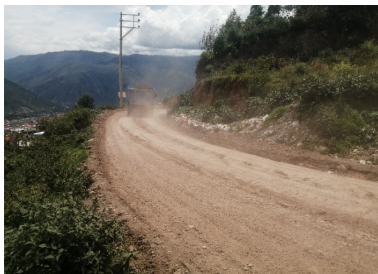
Figura 42. Estado actual de la vía de evitamiento
