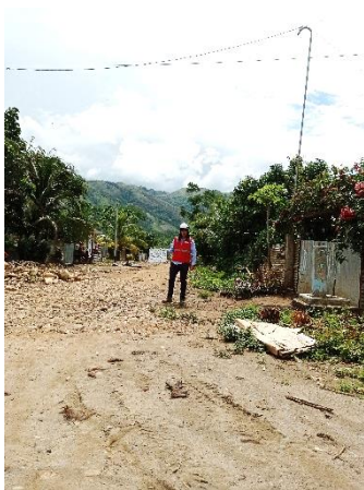
Imagen 9. Vista panorámica de la calicata C-03.
