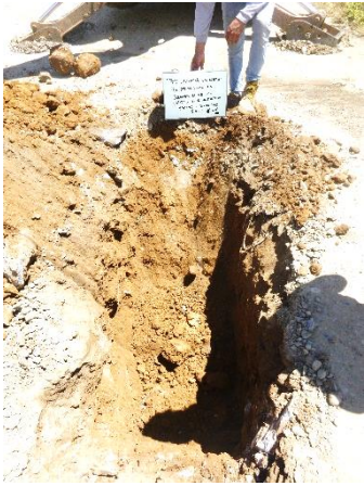
Imagen 1. Vista de la calicata C-01.
