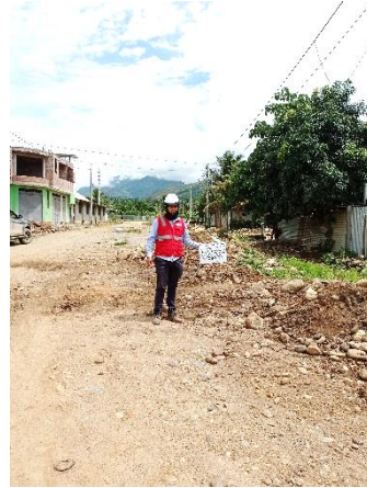
Imagen 8. Vista panorámica de la calicata C-02.
