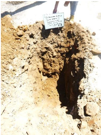
Imagen 5. Vista de la calicata C-03.
