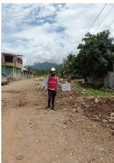
Figura 18. Se observa la Calicata 02.
