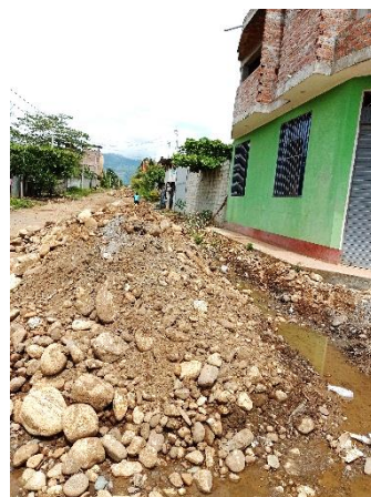
Imagen 12. Vista panorámica del Jr. Mantaro.
