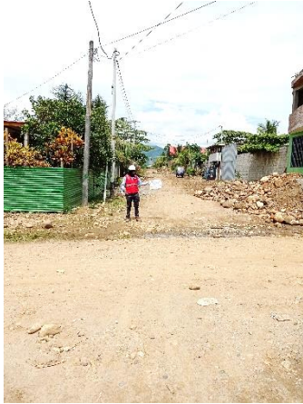
Imagen 7. Vista panorámica de la calicata C-01.
