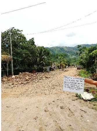
Imagen 11. Vista panorámica del Jr. Mantaro.
