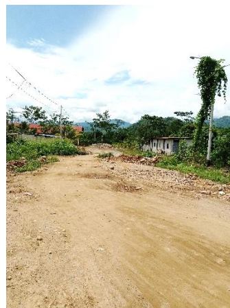
Imagen 10. Vista panorámica del Jr. Mantaro.
