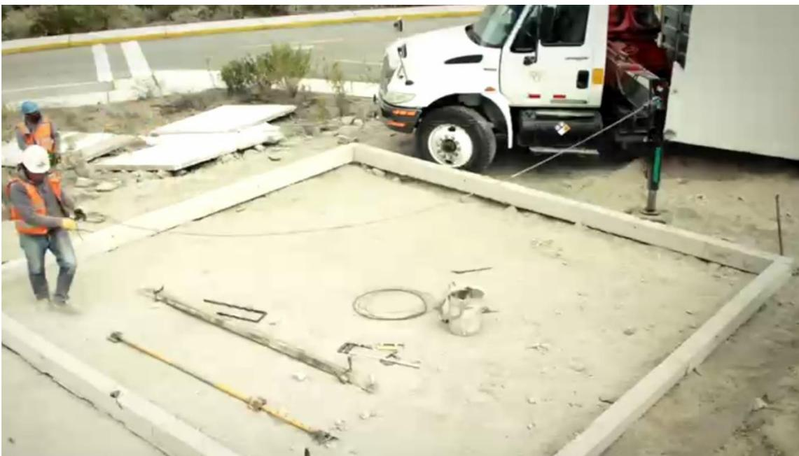
*Figura 37. Colocación de encofrado perimetral*
