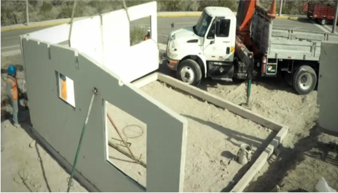
*Figura 38. Instalación de muros*
