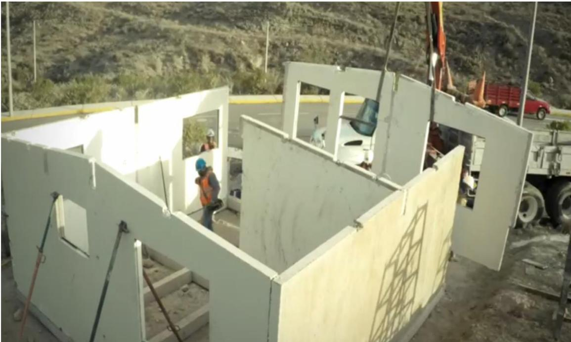
*Figura 39. Acoplamiento de muros*
