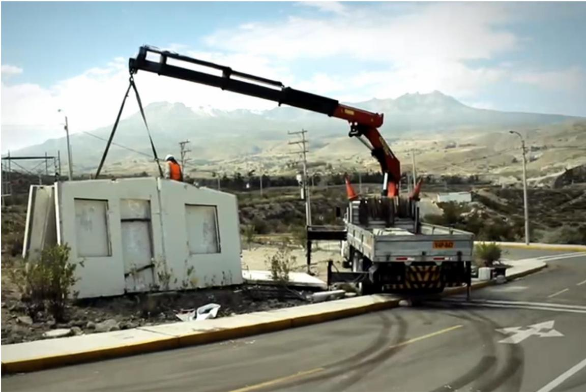
*Figura 36. Transporte de muros*
