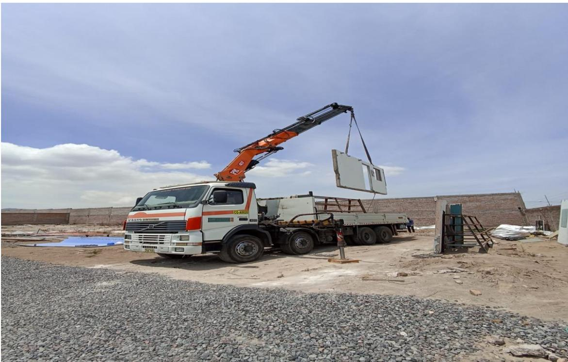
*Figura 35. Traslado de muros*
