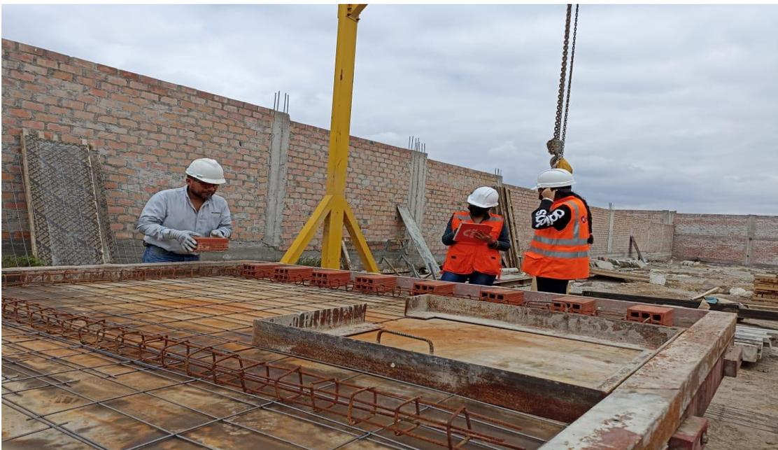
*Figura 31. Colocación de ladrillo*
