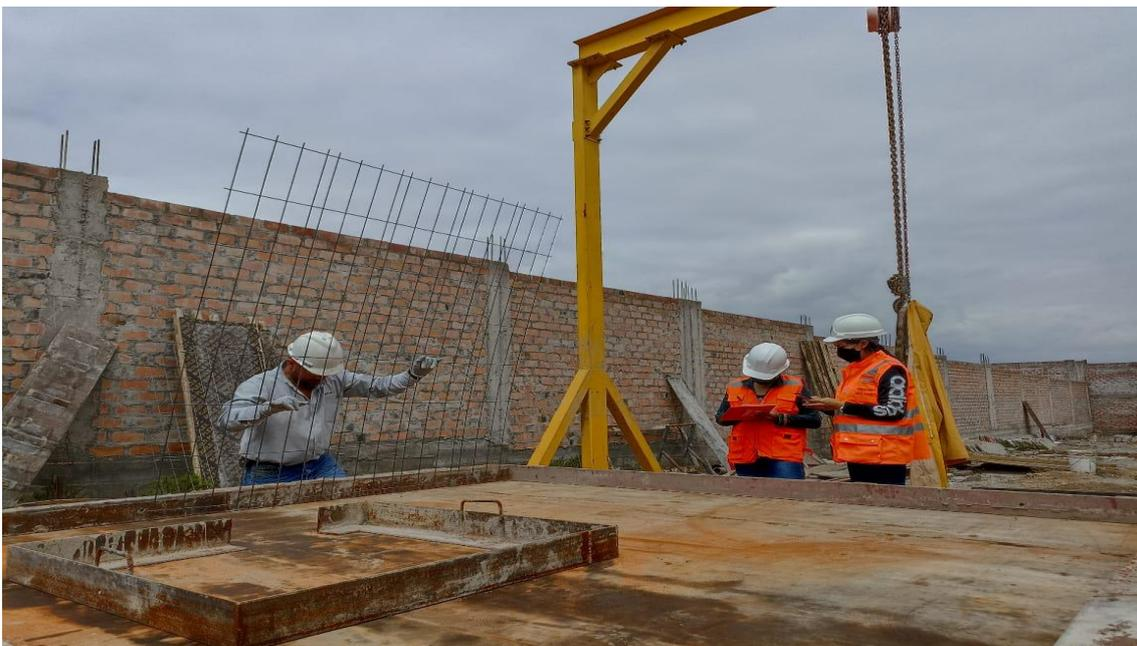
*Figura 29. Colocación de malla de acero*
