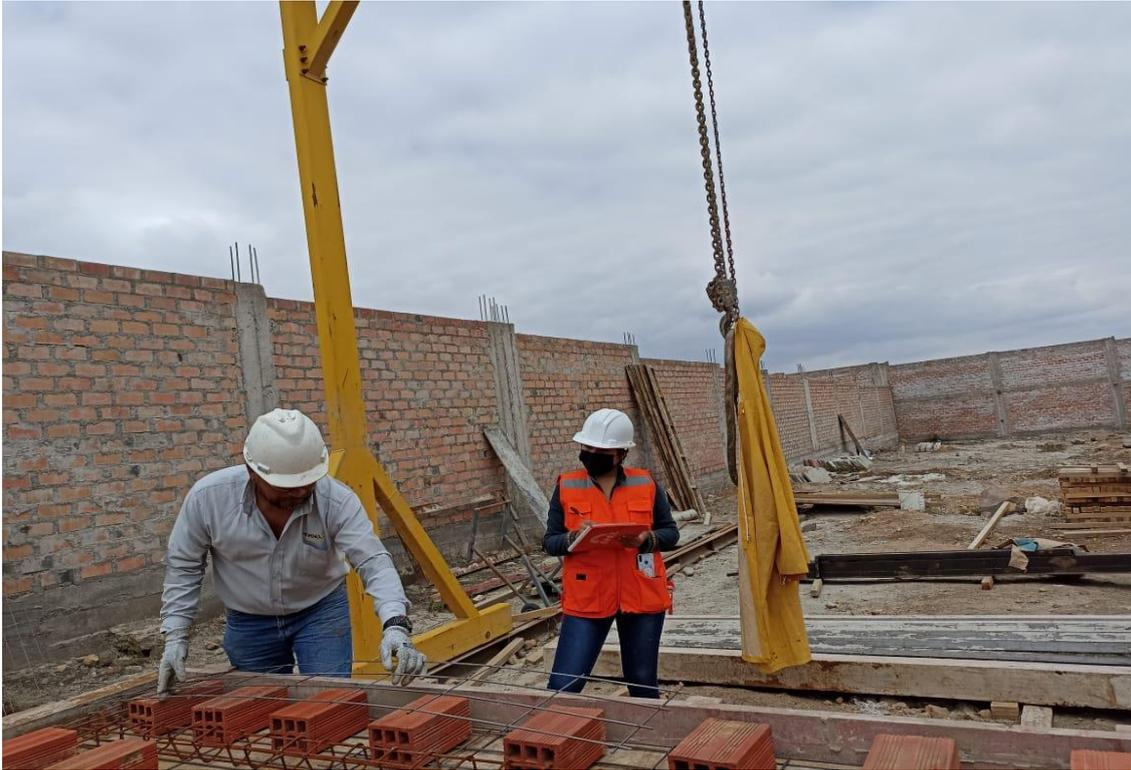
*Figura 32. Colocación de malla de acero*
