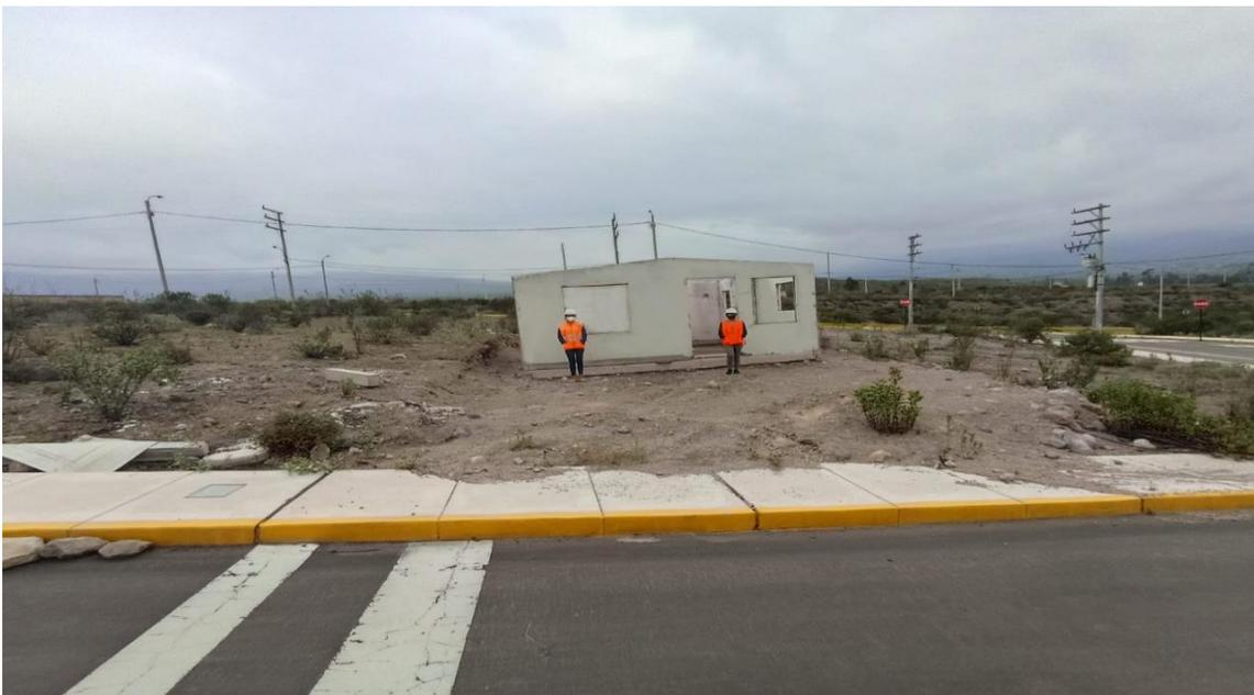
*Figura 41. Casa de 1 planta de 36m2 en casco gris*
