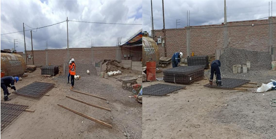
*Figura 28. Traslado de malla de acero*
