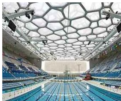
Figura 53. Estructura ETFE irregular e inflada siguiendo las reglas de Plateau.
