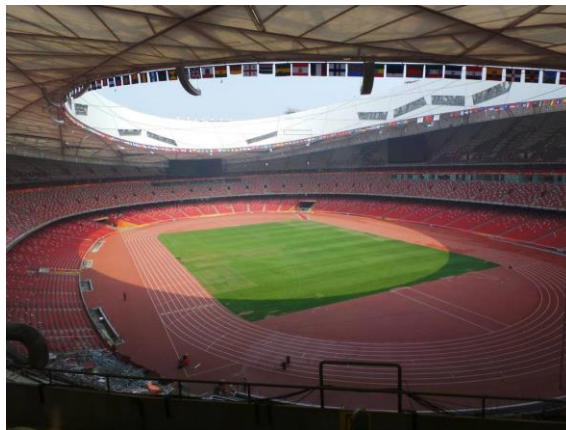
Figura 64. Planta del Estadio Olímpico Nacional de Pekín. Interior del Estadio Olímpico Nacional de Pekín.
