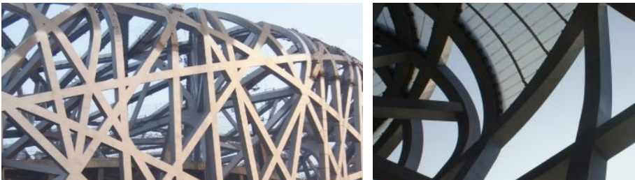
Figura 58. Detalles en el techo del Estadio Olímpico Nacional de Pekín.
