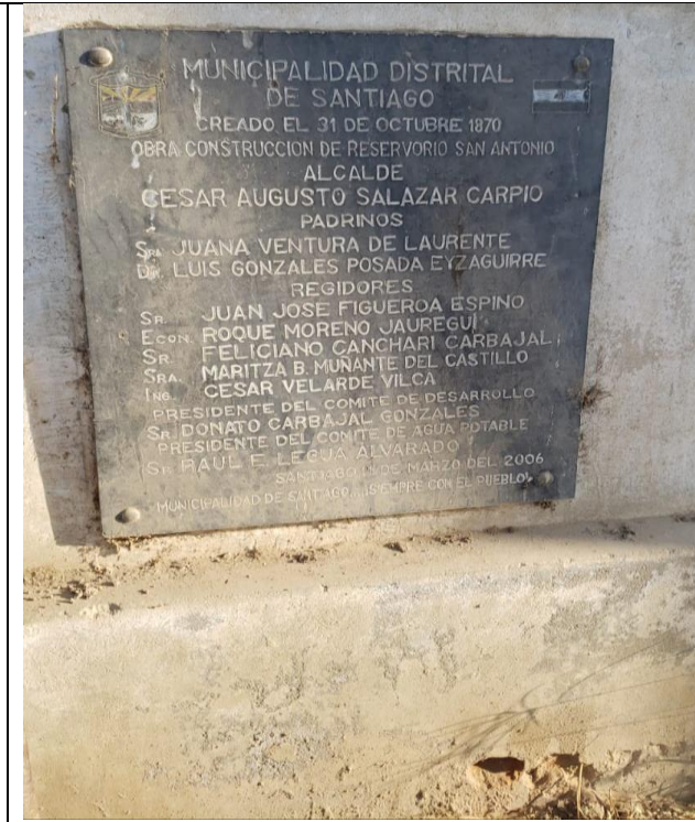
Reservorio elevado aporticado de 50 m3 con una altura de 15 m, actualmente se encuentra fuera de servicio
