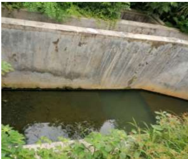
Foto N° 13-14. Sedimentador-EPS EMAQ
