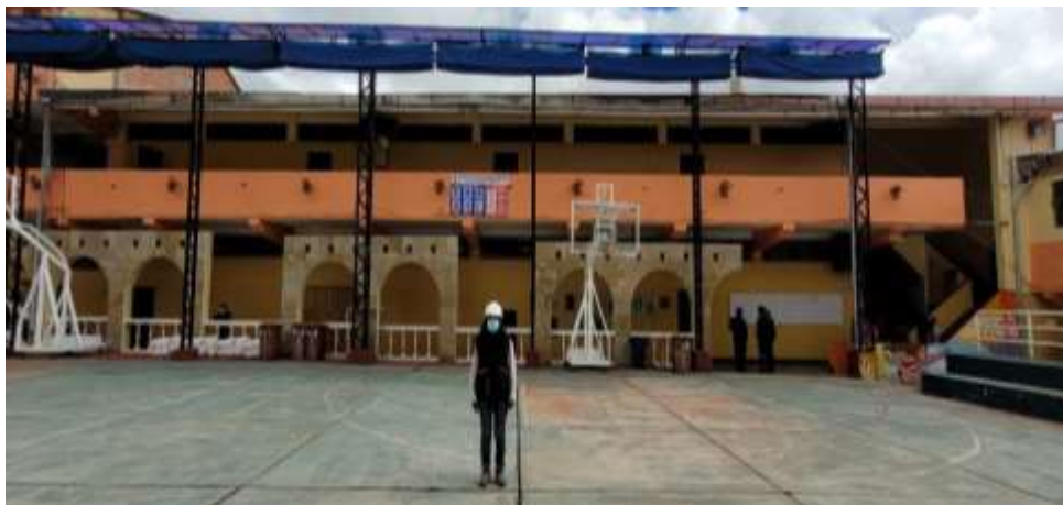
Figura 23: Vista frontal del pabellón B
