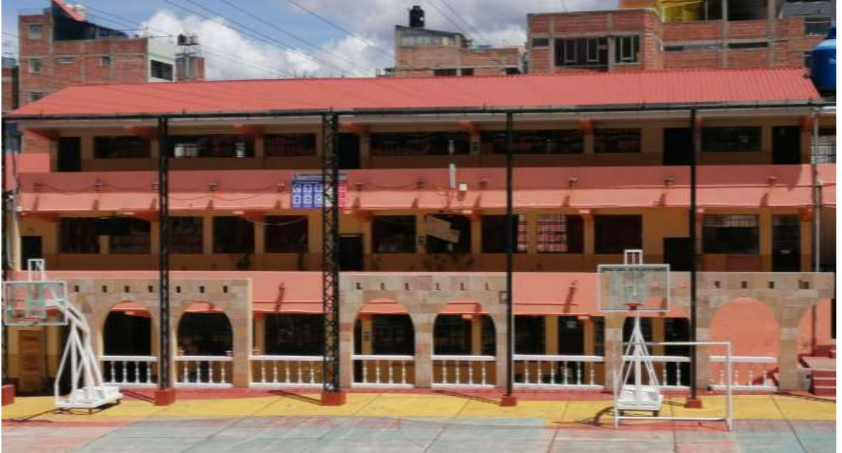
Figura 24: Vista frontal del pabellón C
