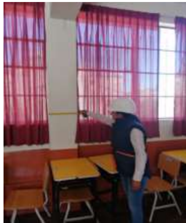
Figura 27: Medición y verificación del estado de la columna
