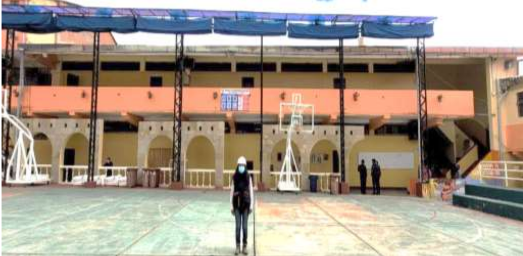
figura 31: Vista frontal del pabellón B
