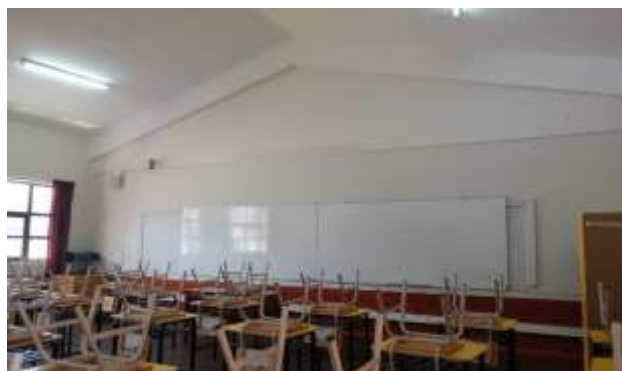
Figura 34. Viga que soporta la cubierta del pabellón B
