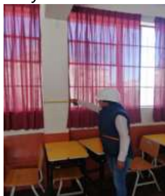
Figura 32. Medición y verificación del estado de la columna
