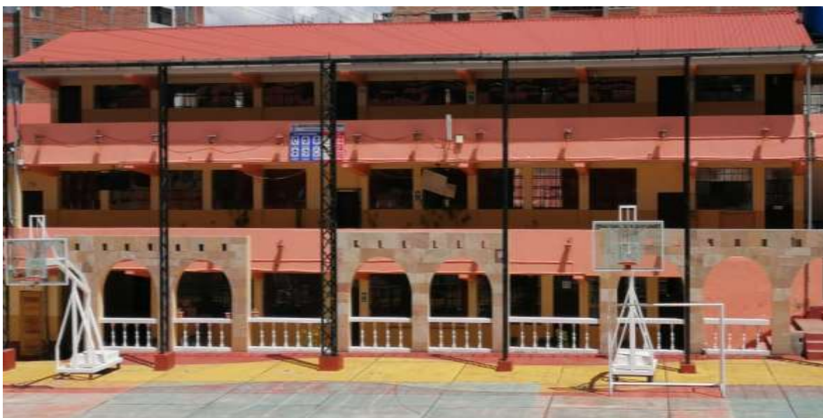
figura 36. Vista frontal del pabellón C
