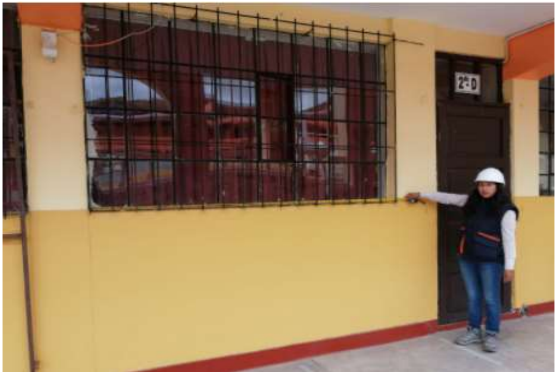
En esta fotografía se aprecia la medición de ventanas.
