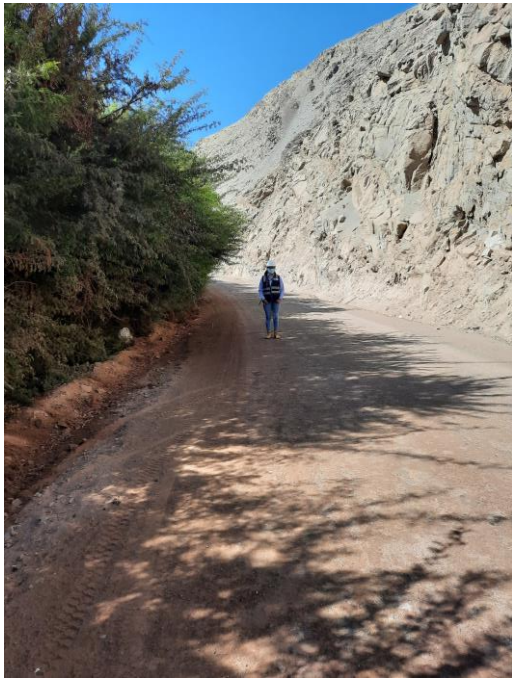
Fotografía 5: Reconocimiento de carretera EMP.MO 534 Fundo El Hueso km 0+000
