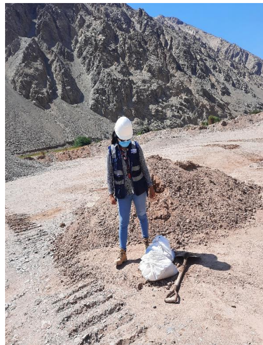
Fotografía 16: Extracción de material granular afirmado de la cantera ubicada en el tramo final de la carretera EMP.MO534 Fundo El Hueso
