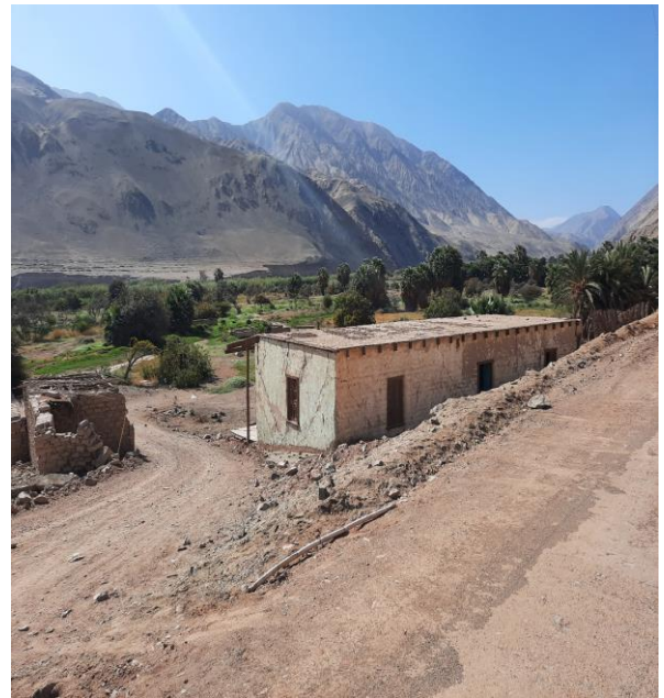
Fotografía 10: Reconocimiento de carretera EMP.MO 534 Fundo El Hueso km 4+000
