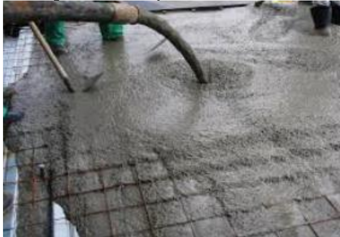
Figura 22: Trabajabilidad del concreto
