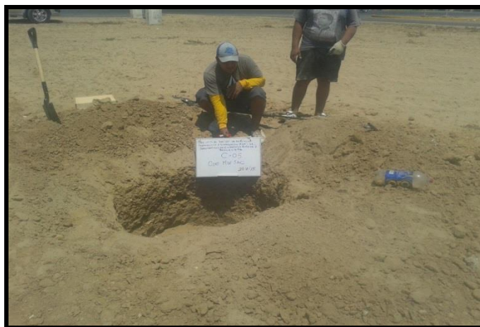
Calicata C-5 Ubicada en la avenida Buenos Aires
