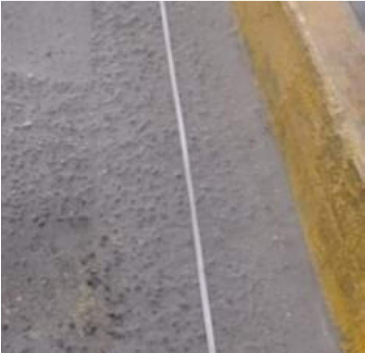
Figura 15. Parcheo y acometidas de servicios públicos. Elaboración propia (2022)
