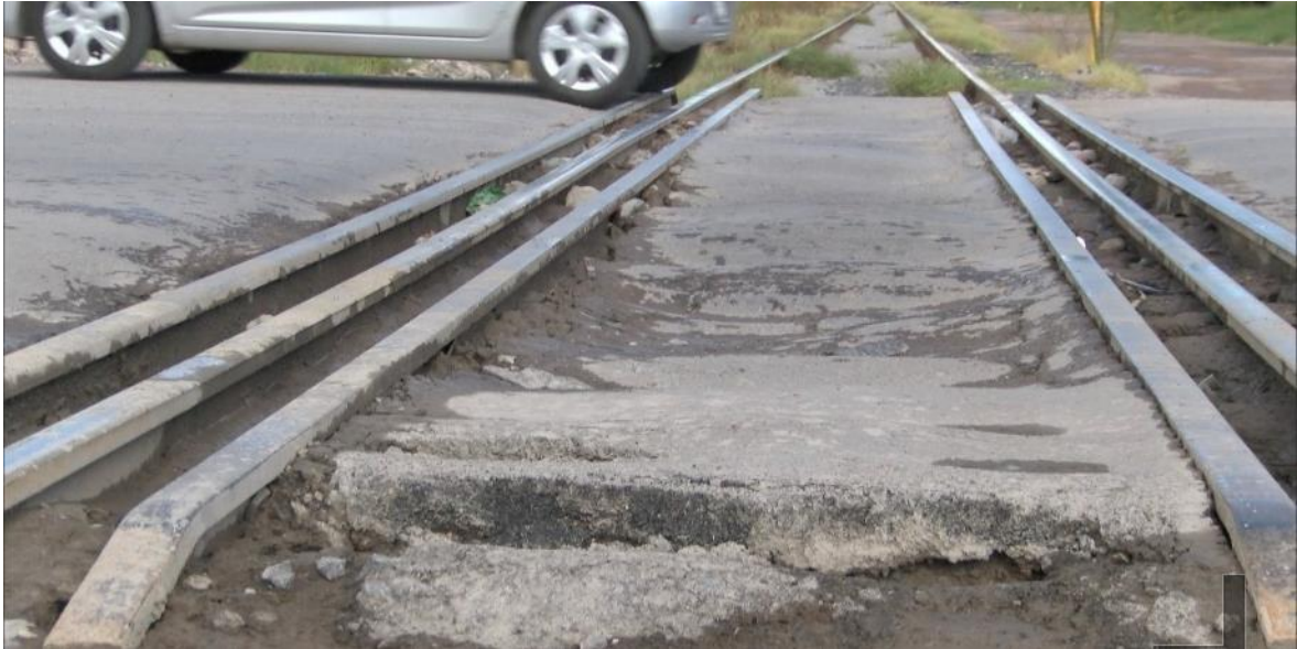
Figura 18. Cruce de vía férrea. Televisa Regional (2019)
