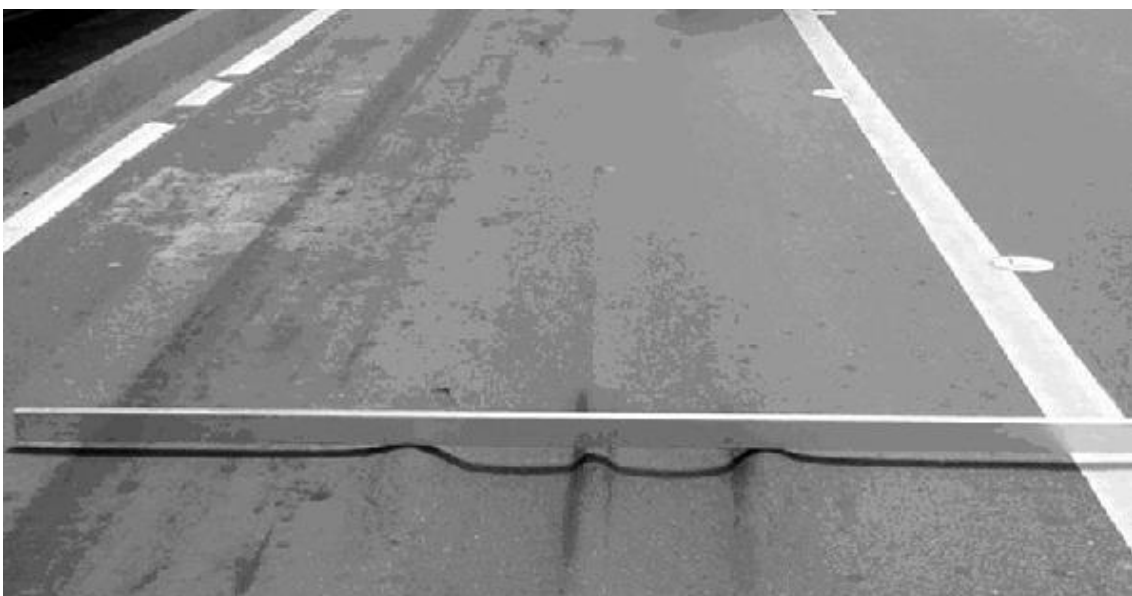
Figura 19. Fenómeno del ahuellamiento. Reyes Lizcano (2011)
