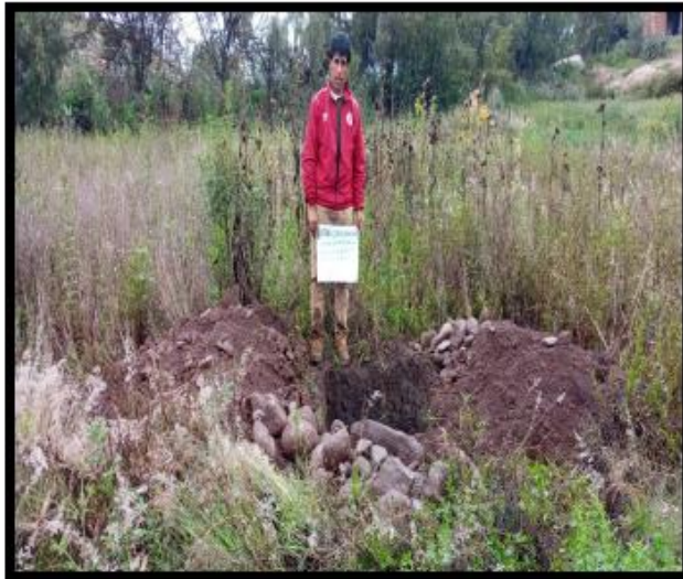
Fotografía N°02.-Calicata C-01, excavada en la edificación.
