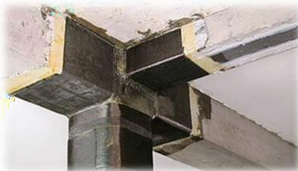
Figura 11. Reforzamiento en columnas y vigas (zona de confinamiento)
