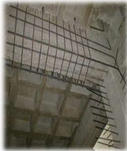
Figura 8. Encamisado de viga
