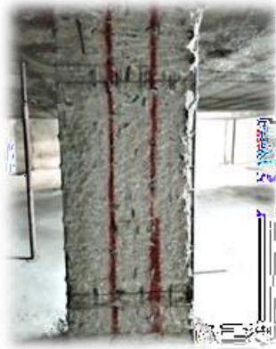
Figura 3. Remoción de recubrimiento de la columna a reforzar
