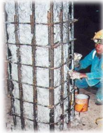
Figura 6. Aplicación del puente de adherencia
