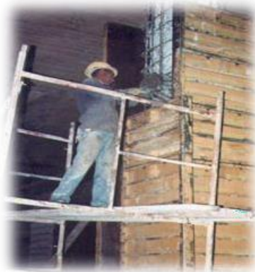
Figura 7. Encofrado de columna
