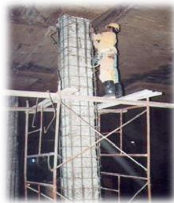
Figura 5. Colocación del refuerzo longitudinal
