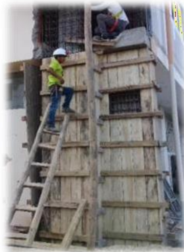
Figura 10. Encofrado de placa
