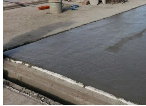
Figura 2. Etapa de fraguado del Pavimento rígido
