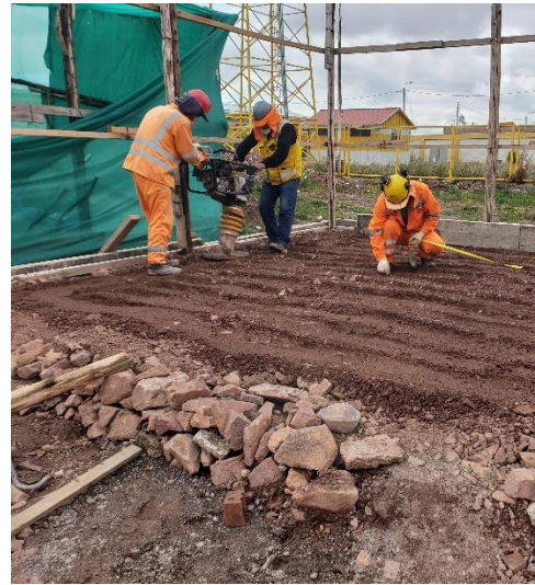
Figura 34. Compactado de sub base granular
