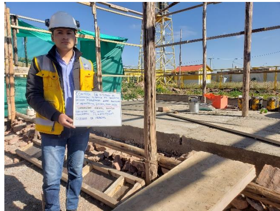
Figura 36. Fraguado final de las losas de concreto
