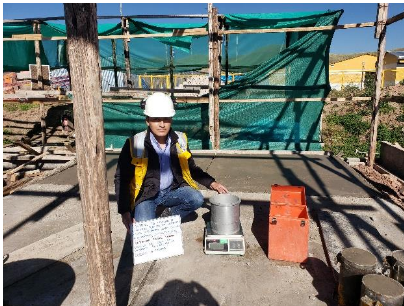
Figura 41. Realización de ensayo de Peso unitario y rendimiento del concreto
