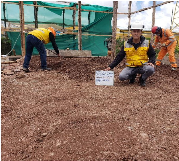
Figura 33. Perfilado y nivelado de sub base granular
