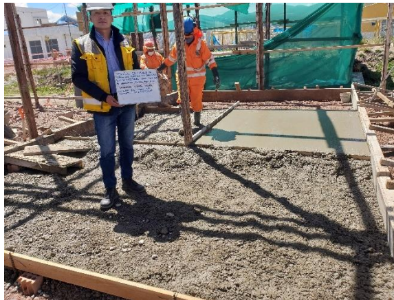
Figura 35. Inicio de vaciado de losas
