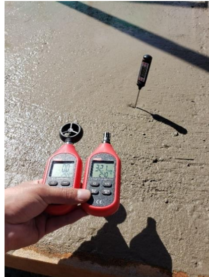
Figura 40. Toma de datos de temperatura del concreto
