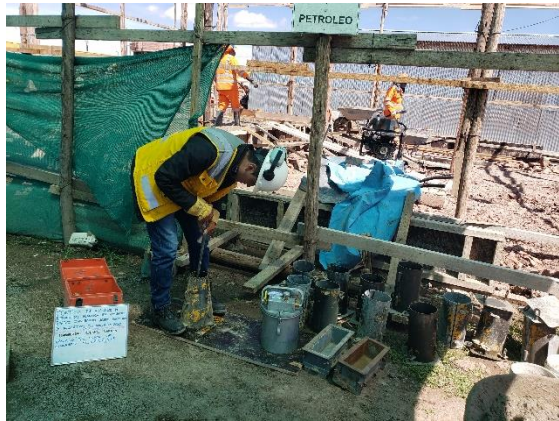
Figura 37. Realización de ensayos de revenimiento
