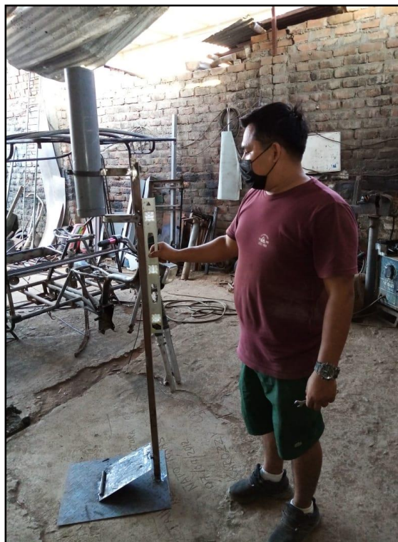
Colocación del cilindro de PVC de 50 cm de altura y 4'' de diámetro también la verificación correcta que este a nivel.
