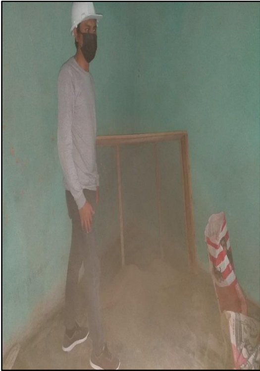
Tamiz de 4'' para el suelo para la preparación del adobe Patrón
