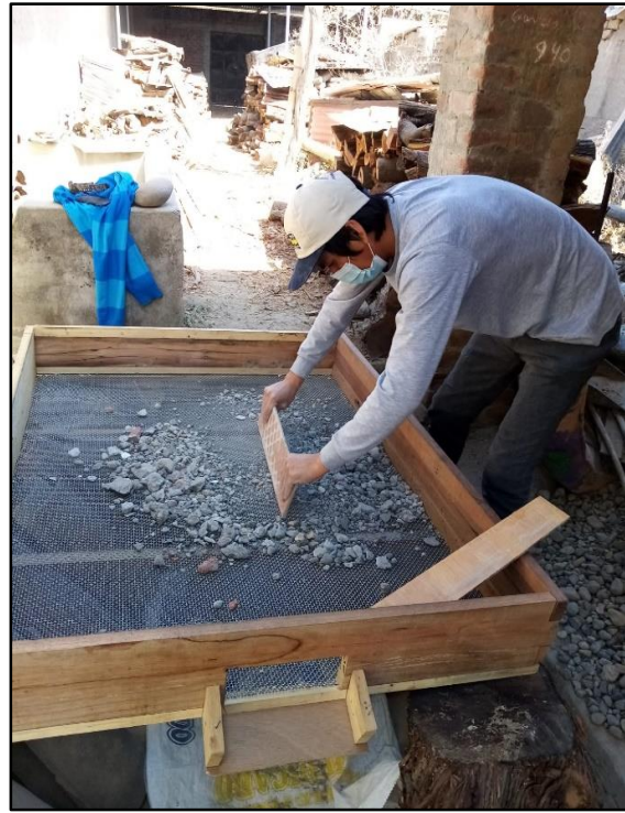
Con ayuda de una madera se procede a mover de forma pareja para que el tamizado sea homogéneo y rápido.
