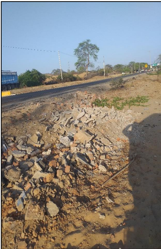
Ubicación de botaderos de los Residuos de Construcción y Demolición.
