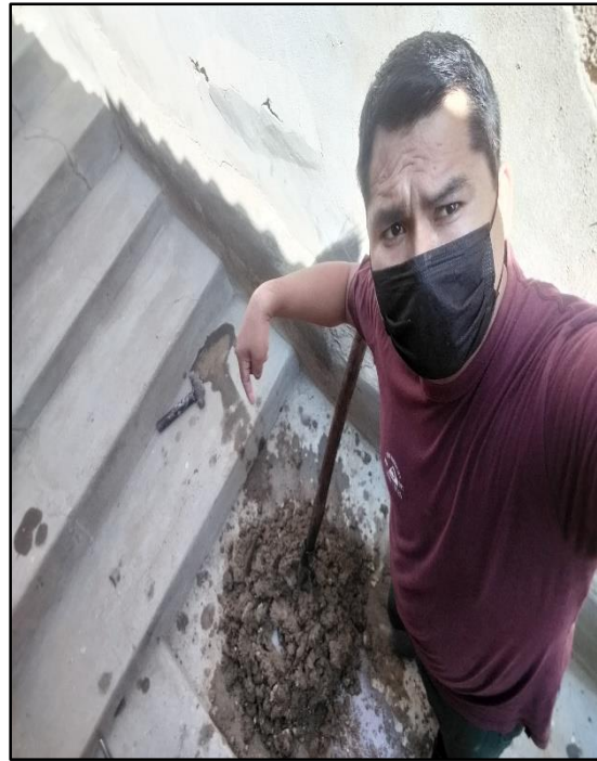
Previo mezclado del barro con FSP y RCD.
