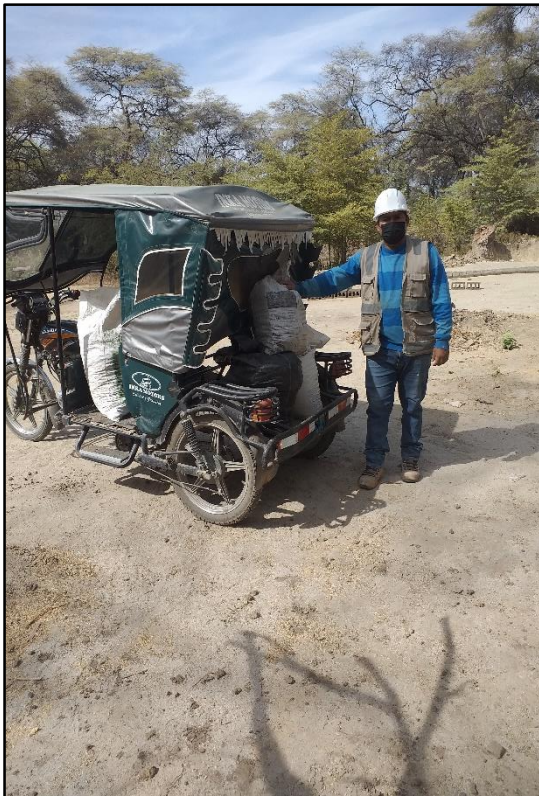
Listos para trasladar el material (Suelo).
