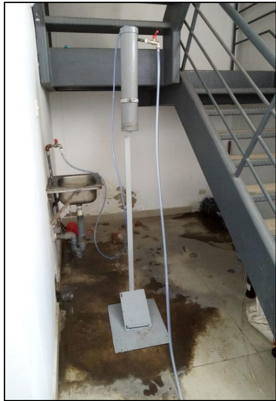
Se muestra la maquina completa en contacto directo con un caño de agua.
