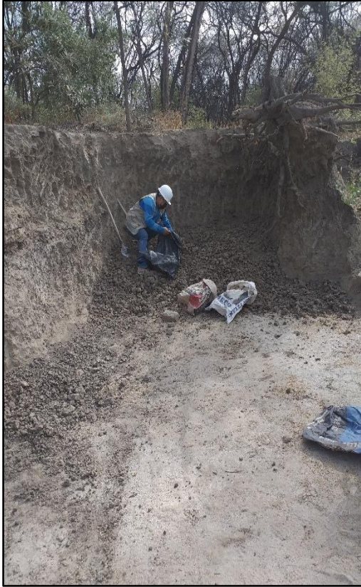
Llenado del suelo en sacos para trasladar el material a otro lugar.
