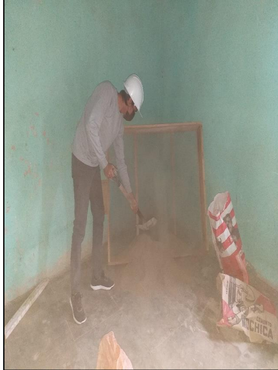
Se comenzó con el tamizado y limpieza de Materia Orgánica del suelo.
