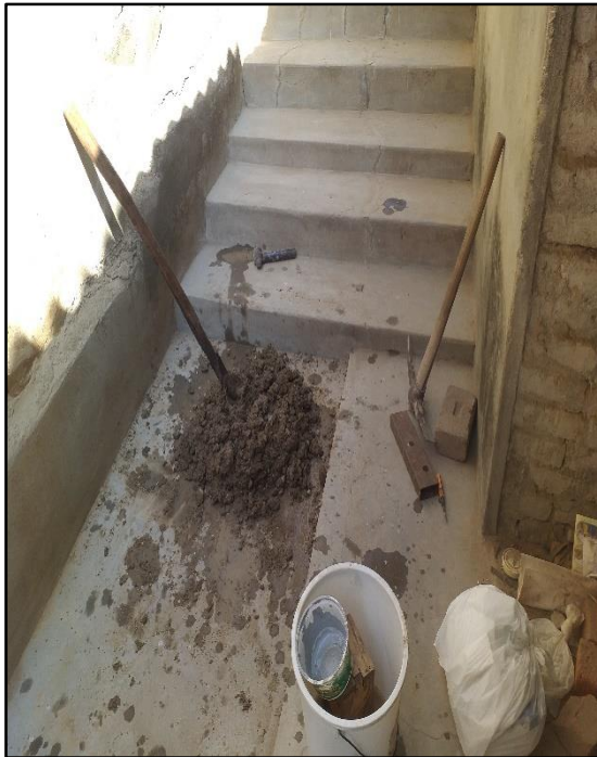
Remojo y reposo de suelo por cantidades ya pesadas durante 24 horas que facilitarían luego el mezclado.
