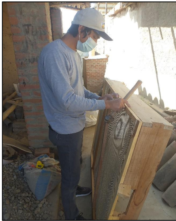
En el contorno de la malla reforzada con madera para que tenga mayor consistencia.
