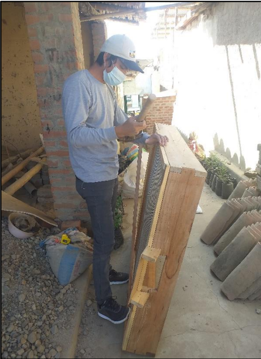
Elaboración de un tamiz con una malla de 4 mm basado en la norma E-0.80
