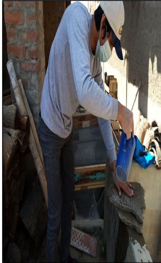
Lavado de los RCD para previo secado.
