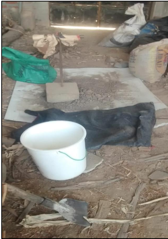
Trituración del suelo con ayuda de un pisón. y un latón grueso en la parte de abajo
