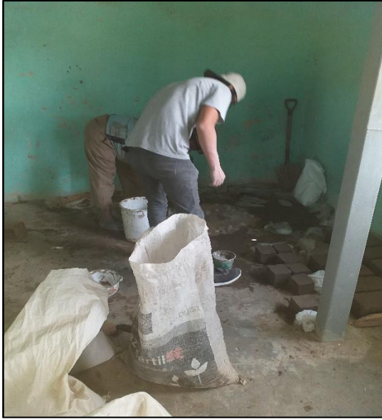
Mezclado de la FSP y RCD junto con el barro.
