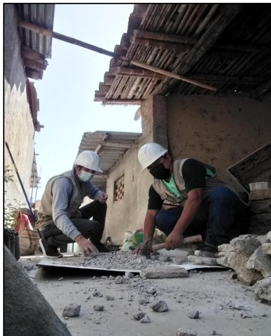
Trituración manual de los RCD usando una comba-martillo.
