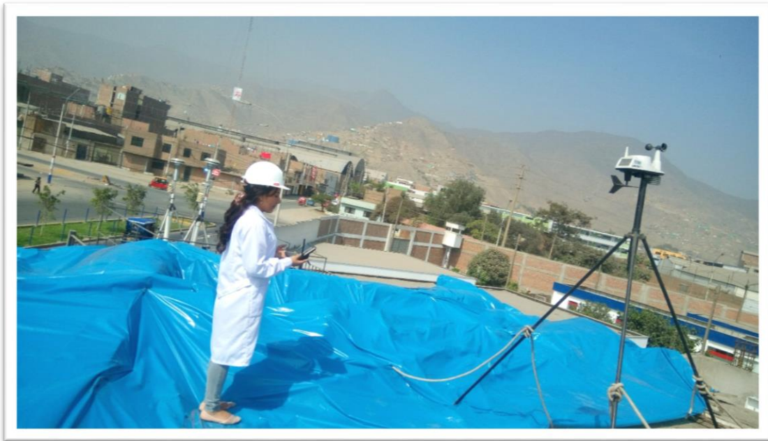
Foto N° 01: Instalación de la Estación Meteorológica
