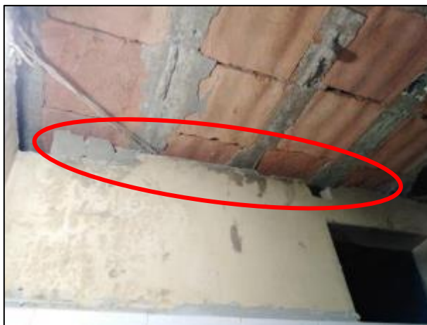
Figura 33 Unión muro techo
