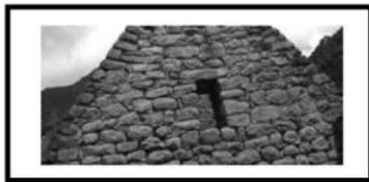
Figura 4 Primeras construcciones de albañilería
