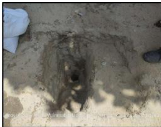
Figura 27 Realización de excavación calicata C-2
