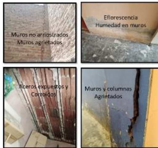
Figura 40 Factores degradantes de vivienda con vulnerabilidad sísmica alta
