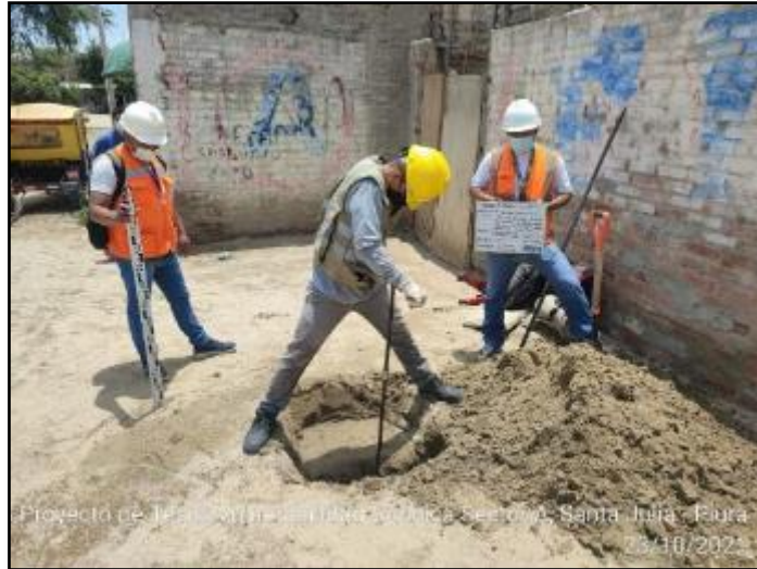
Figura 25 Realización de exploración de suelos con herramientas manuales
