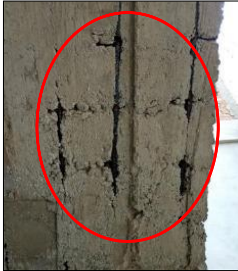
Figura 34 Armaduras expuestas
