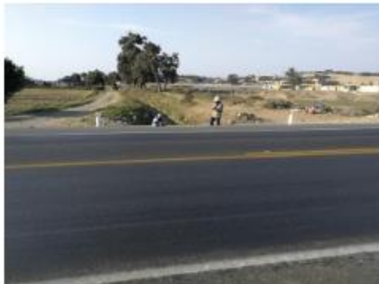
Imagen N°2: Colocando Puntas de Señalización
