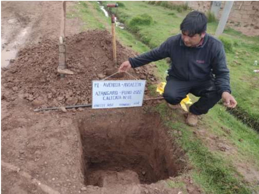
Fotografía 01. Apertura de calicatas
