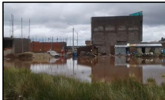
Figura N° 39 se aprecia la vivienda Inundada por el desborde del rio
