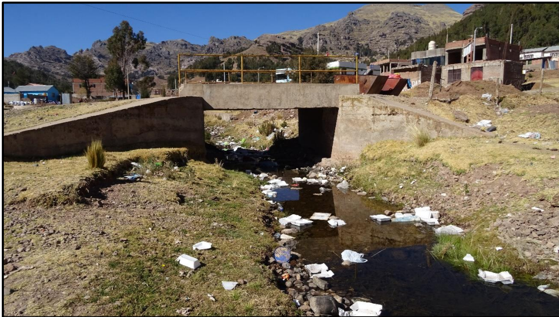
Fotografía N° 6. Vista Frontal aguas abajo del puente sobre el tributario del rio Jayllihuaya, en la calle Incapugio.
