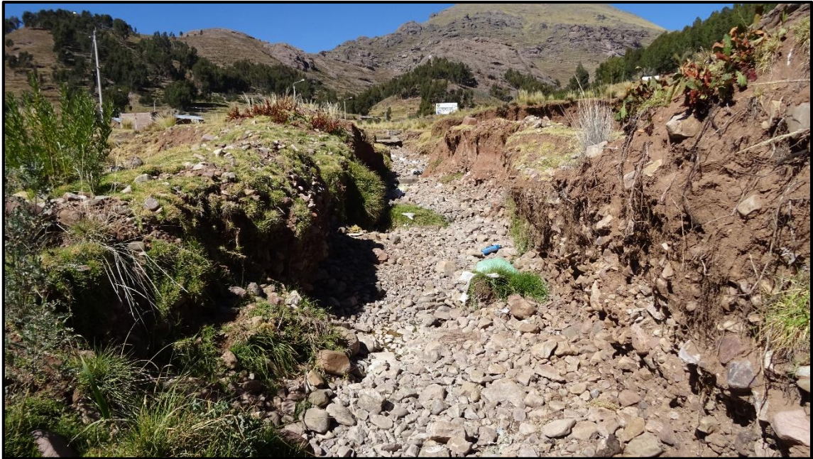
Fotografía N° 9. Vista del cauce de la quebrada Vizcachani
