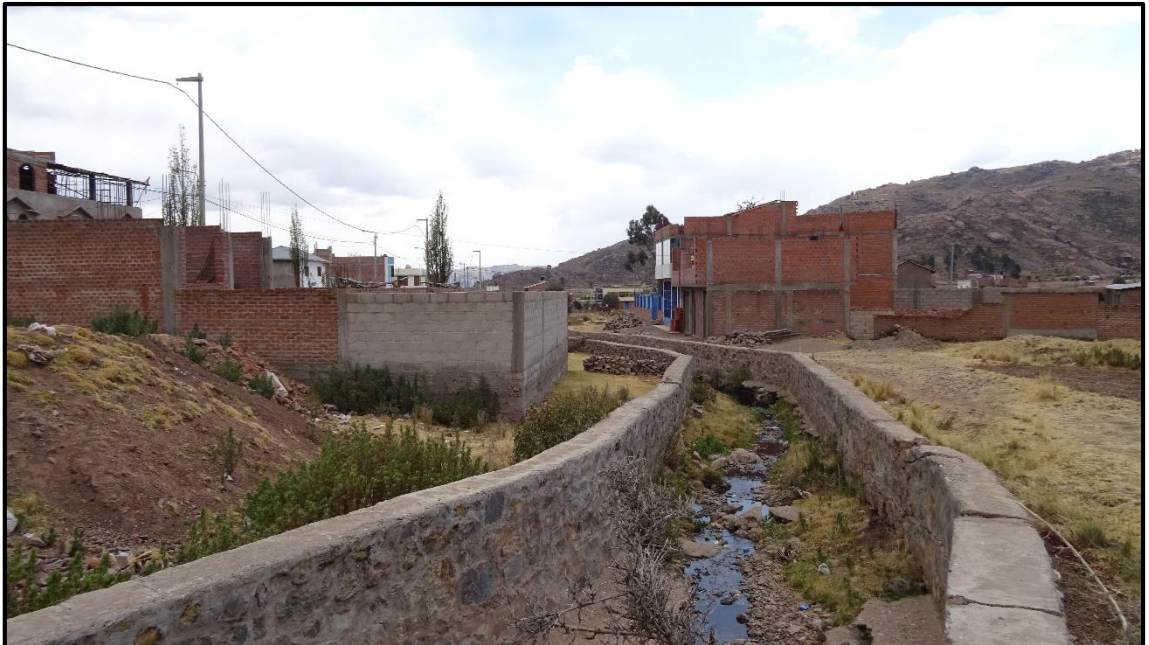
Fotografía N° 4. Riachuelo a travessando la población, encauzado con mampostería de piedra.
