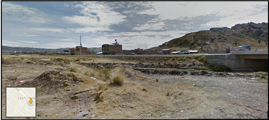
Imagen N° 5. Vista frontal del Puente principal sobre el riachuelo Jayllihuaya, zona por donde se canalizará.
