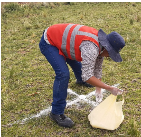
Figura 38, se observa el marcado de puntos de foto control.
