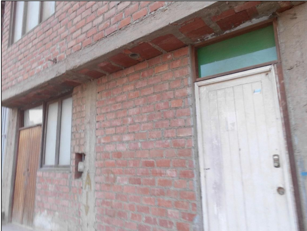
Figura 3. El hexágono para la entrada de luz se encuentra ubicada en las viguetas. Fuente propia.
