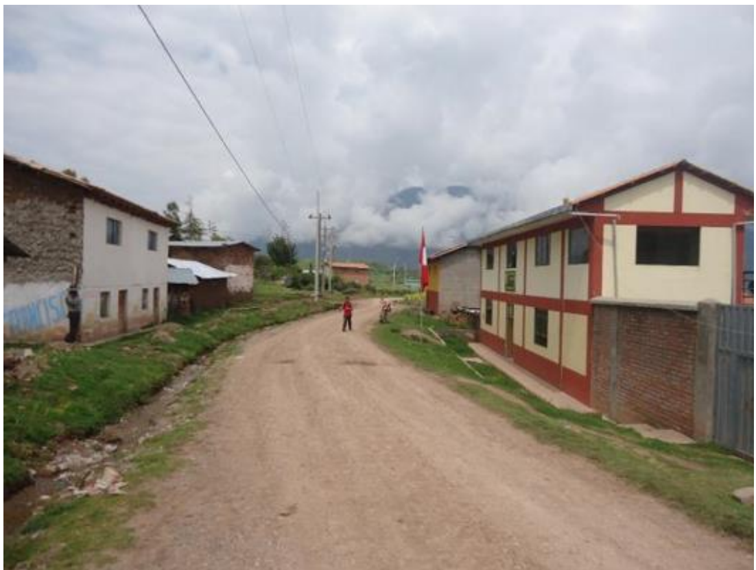
Falta Señalización (zona urbana).
