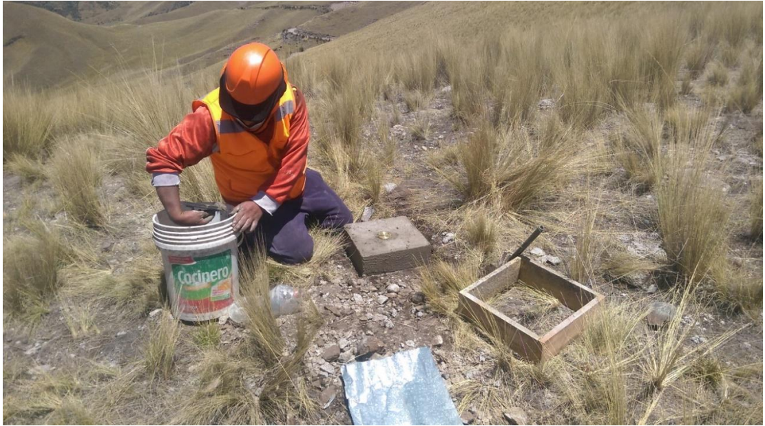
Ubicación y construcción de puntos de Georreferenciación.
