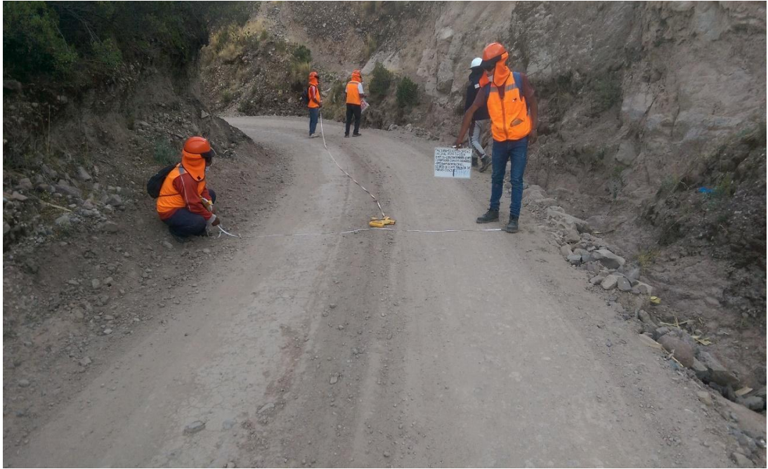
Medición de la vía con wincha, cada 20 m en tangentes y 10m en curvas
