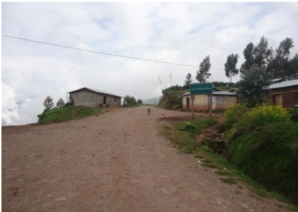
Vía exceso de pendiente
