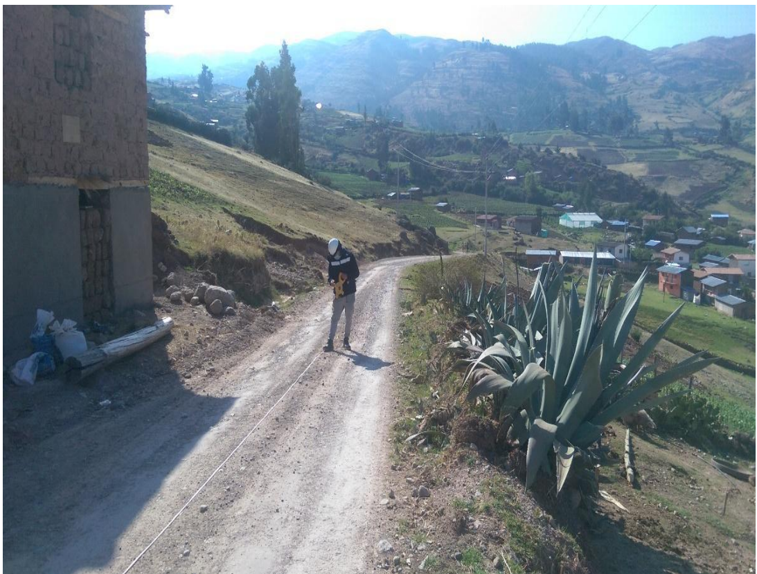
Medición de la vía con wincha, cada 20 m en tangentes y 10m en curvas
