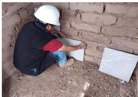
Enchapando las coberturas superficiales interiores en los modelos a escala
