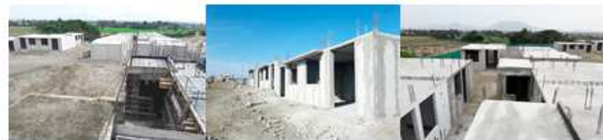
Concreto en muros de ductilidad limitada
