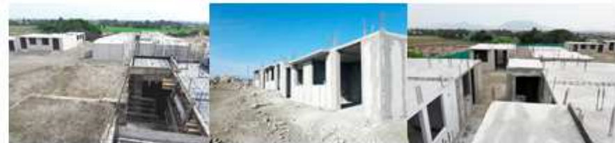
Concreto en muros de ductilidad limitada
