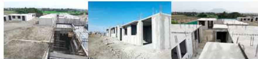
Concreto en muros de ductilidad limitada
