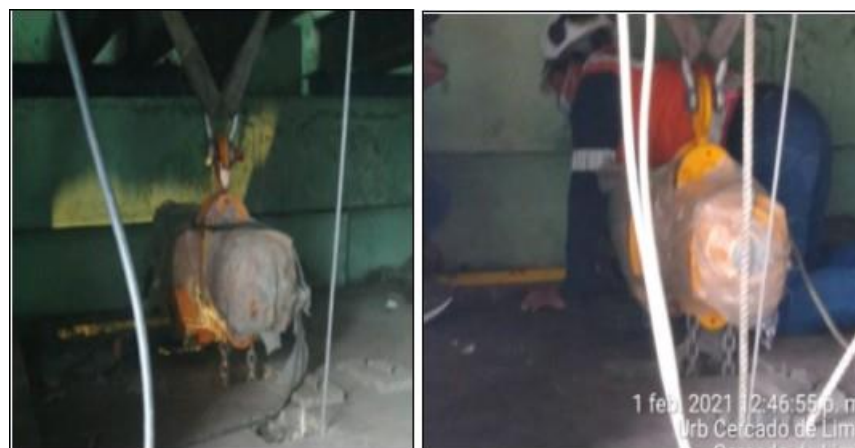
Figura 2. Instalación mecánica de herramientas de izaje en última parada superior
