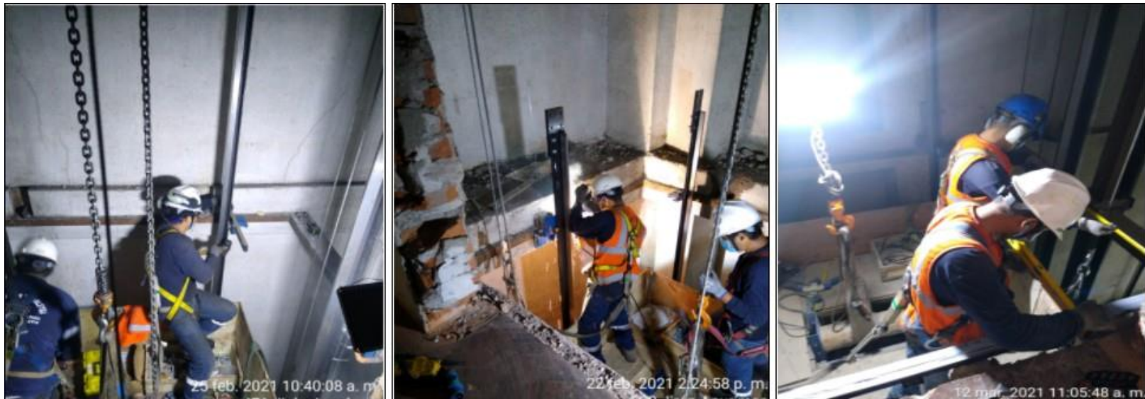
Figura 4. Instalación de plataforma o falso carro
