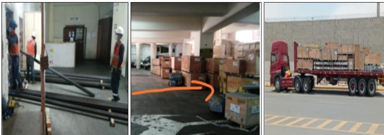
Figura 1. Acarreo de materiales y equipos al ducto
