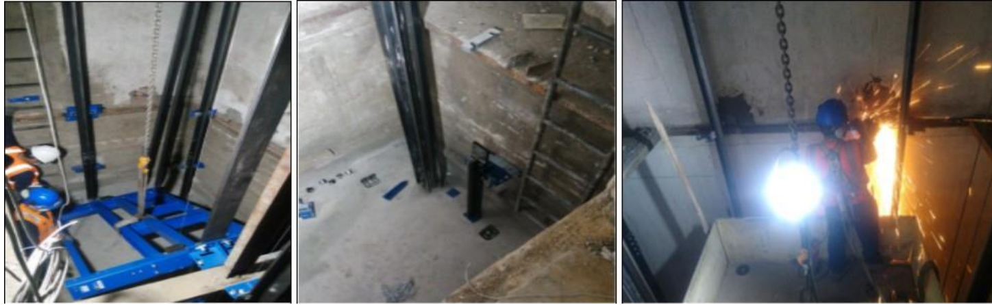
Figura 3. Instalación mecánica de rieles
