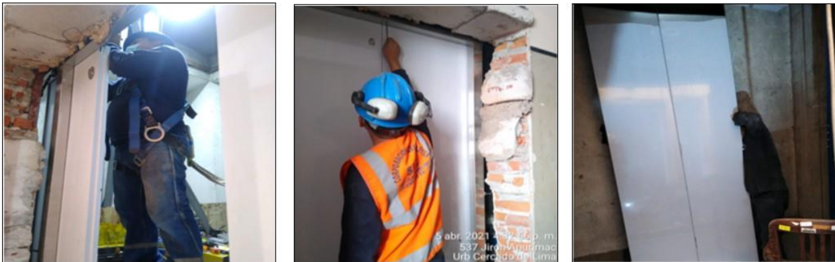
Figura 6. Instalación mecánica de puertas de pasillo
