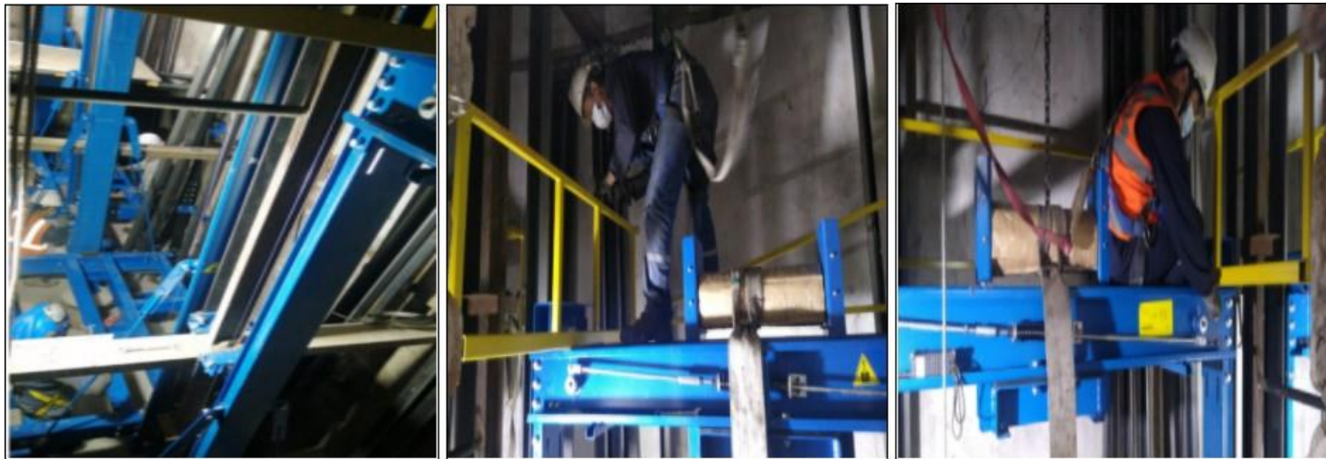
Figura 3. Instalación mecánica de rieles
