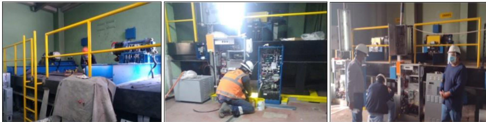
Figura 5. Instalación mecánica del motor
