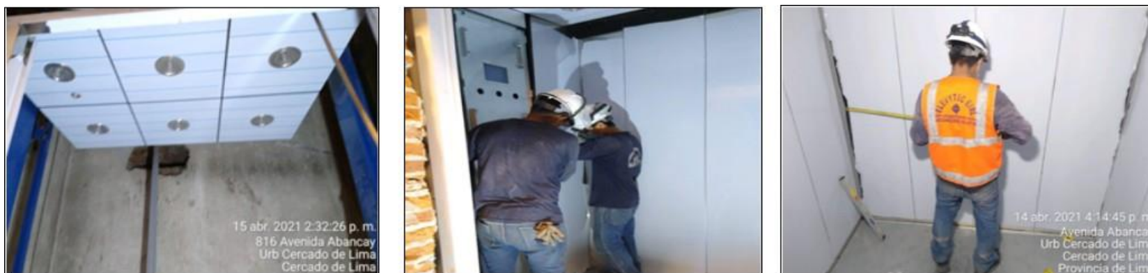
Figura 7. Instalación mecánica de cabina
