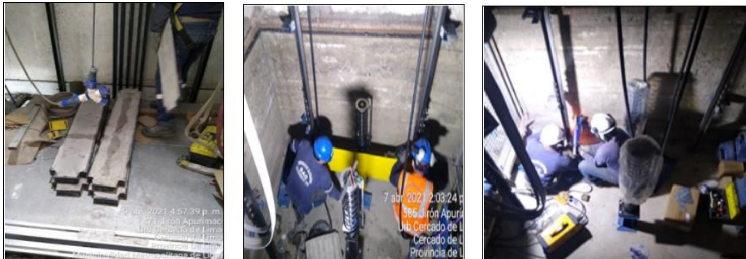
Figura 9. Instalación mecánica de contrapeso en el pit
