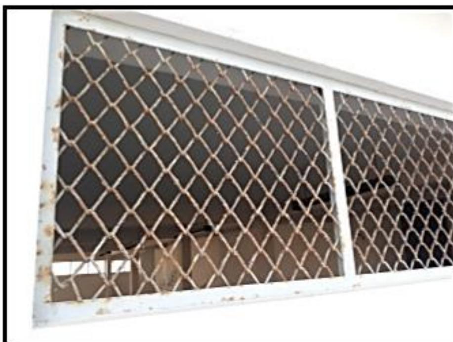
**Imagen N°07:** Se observa oxidación en las ventanas de la caseta de válvulas
