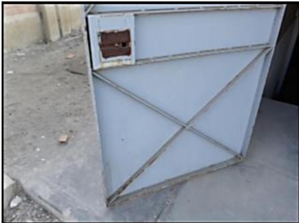
**Imagen N°06:** Se observa oxidación en algunas partes de la puerta de la caseta de válvulas
