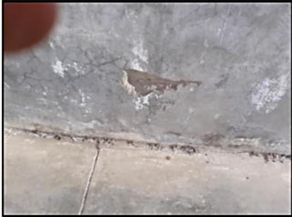
**Imagen N°05:** Se observa desprendimientos superficiales en la estructura de los reservorios en algunas partes determinadas
