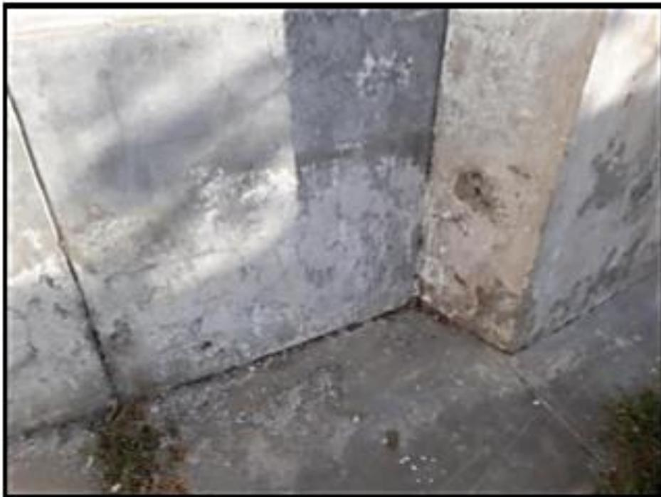
**Imagen N°04:** Se observa que en las partes inferiores de los reservorios existe fisuras y agrietamientos
