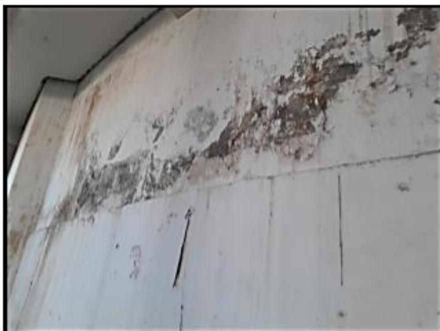
**Imagen N°08:** Se observa filtración y desprendimiento tanto de la pintura como en el concreto en el muro de los reservorios
