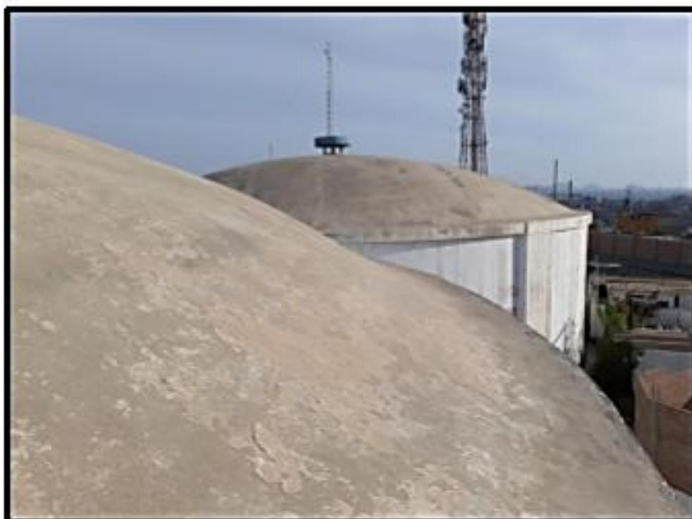
**Imagen N° 09:** Se observa el desprendimiento de la pintura en la cúpula
