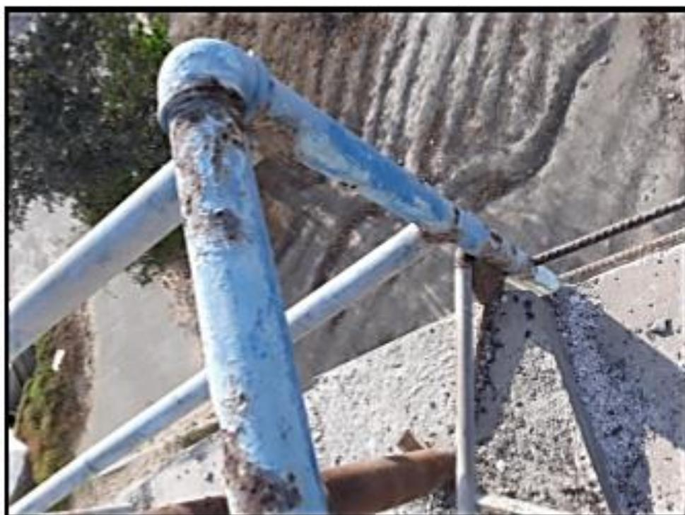
**Imagen N° 10:** Se observa oxidación en las barandas que se encuentra en la cúpula
