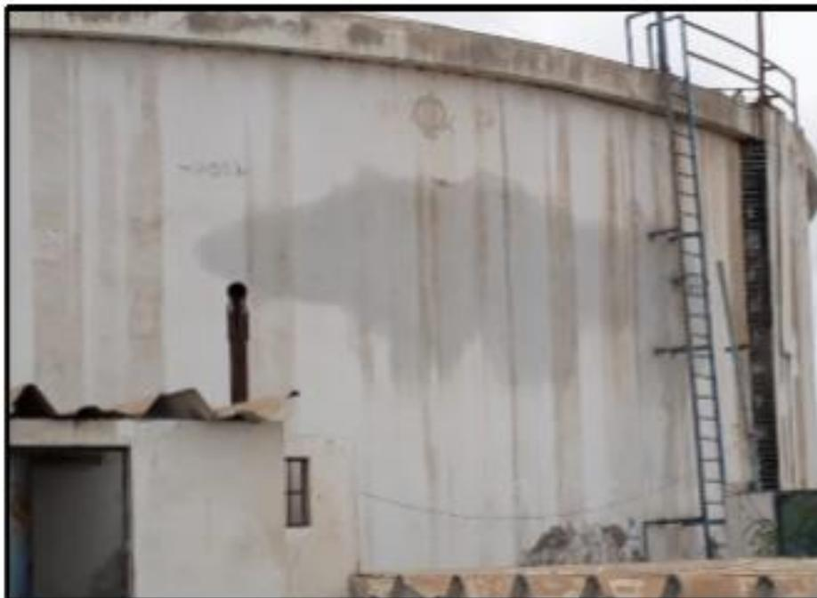
**Imagen N°02:** Se nota filtración en las paredes del reservorio
