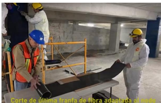
Figura 35. Corte de franja de fibra Figura 36. Encamisado o Refuerzo de Elemento debilitada.
