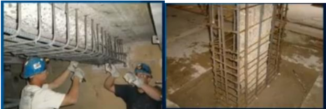
Figura 26. Encamisado de Concreto en Vigas y Columnas
