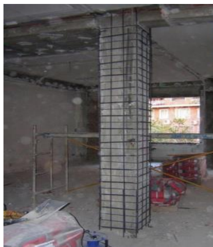
Figura 3. Encamisado en columna de concreto.
