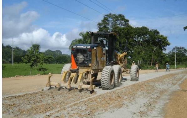
**Figura 1.** Estabilización del suelo
