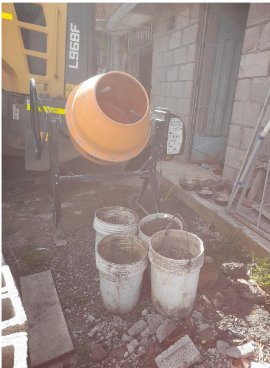
Figura 27. Materiales para la elaboración de las mezclas de concreto.
