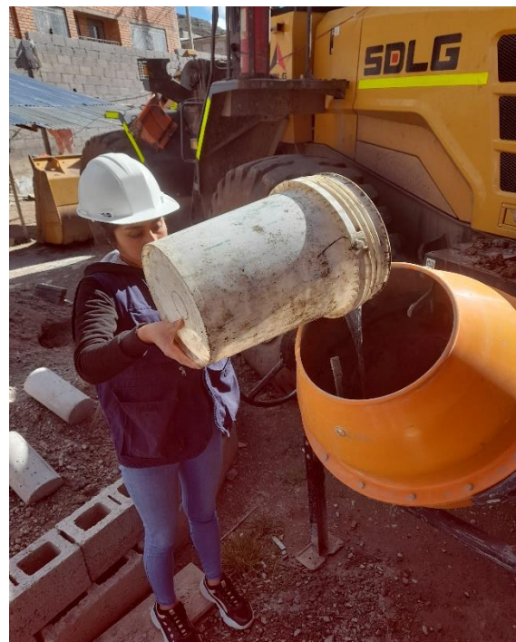
Figura 28. Preparación de la mezcla de concreto
