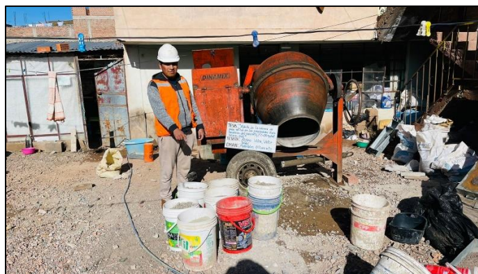
Figura 12: Obtención de los agregados gruesos y finos (Cantera de Yocará)
