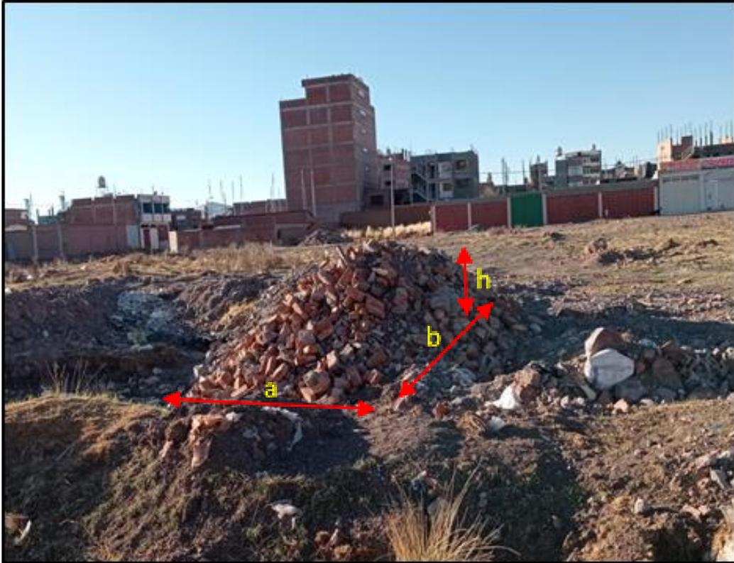
**Fotografía N° 05.** Medidas para la obtención de volúmenes de RCD.
