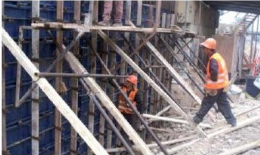
Apuntalamiento del encofrado
