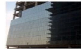
1.- IZADO DE MODULOS
