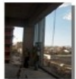
3.- COLOCACION DE MODULO
